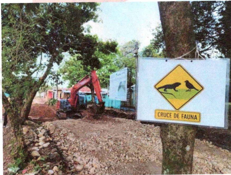
Ilustración 2. señalización en la obra
