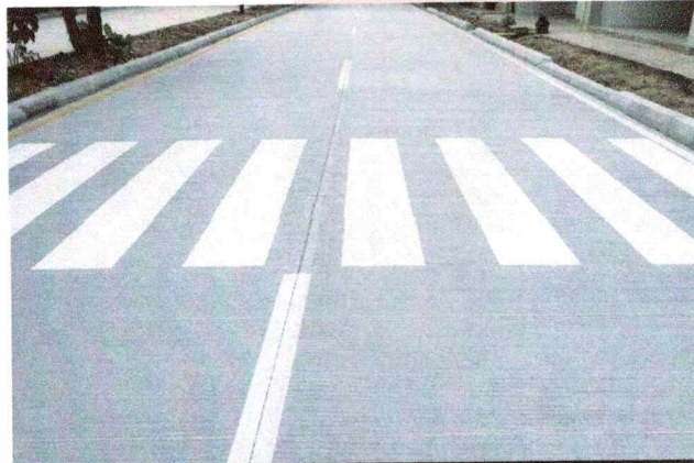
Ilustración 15 líneas de demarcación con pintura en frío
