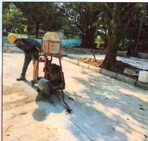
Ilustración 8. Corte de juntas para dilataciones
