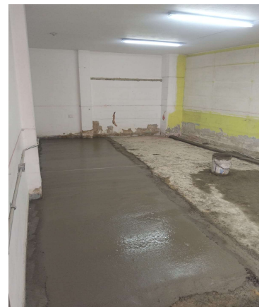
Fundida y nivelación de alistamiento de piso
