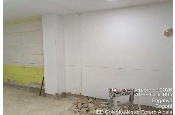
Demolicion de alistado
