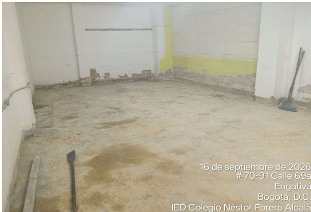
Limpieza de placa base.
