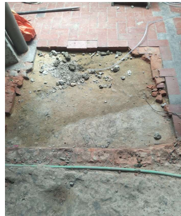
Demolicion de adoquin perimetral al acceso al aula.
