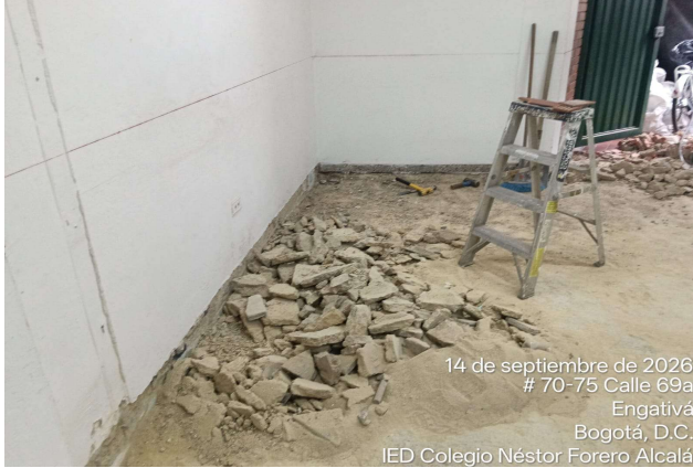
Demolicion de alistado
