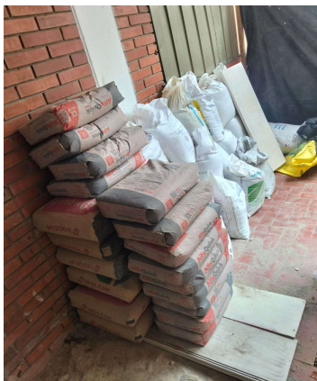
Trasiego de material para fundida piso.
