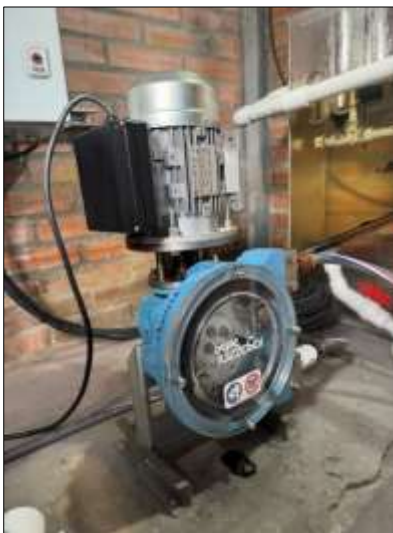
Imagen No. 3 Ejemplo interior estación tipo I mampostería
