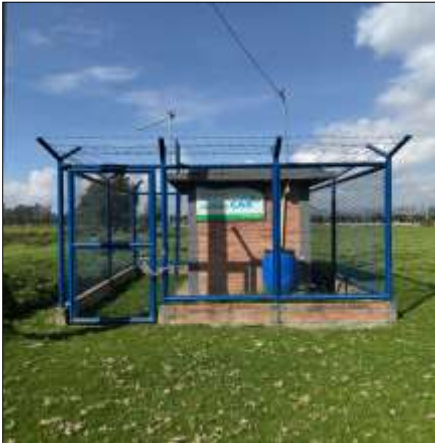
Imagen No. 1 Ejemplo exterior estación tipo I mampostería
