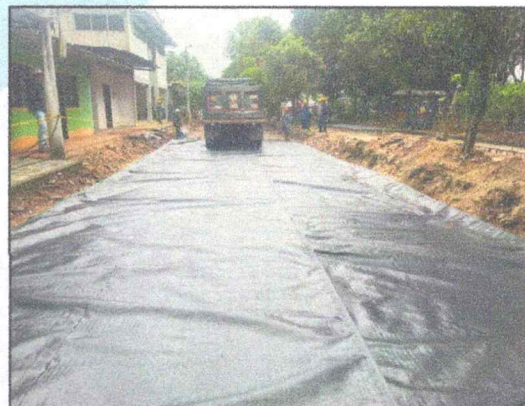
calle 18- Pr 146+00 margen derecha
