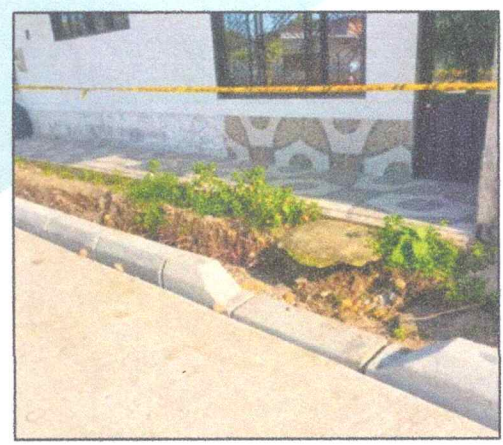
Ilustración 26 sardinel prefabricado tipo a85 (800x200x350 mm) – suministro e instalación
