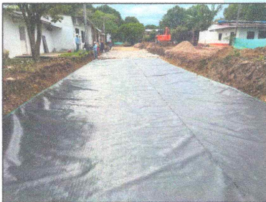
Calle 18 PR 36+00 margen izquierda
