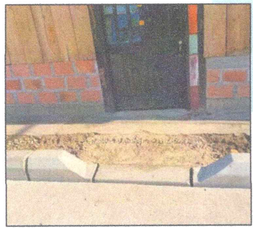
Ilustración 26 sardinel prefabricado tipo a85 (800x200x350 mm) – suministro e instalación
