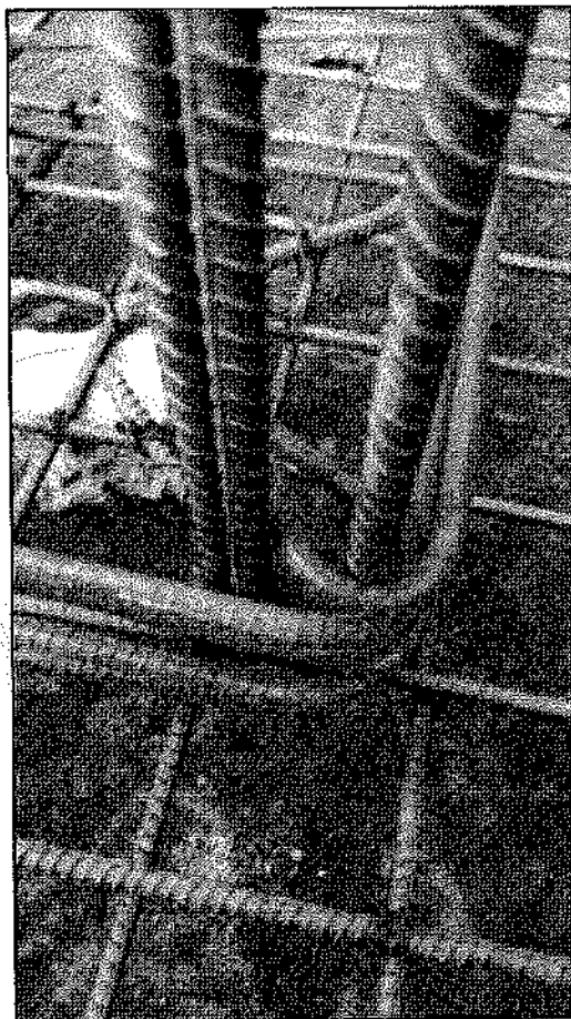
Armado columnas E-7 y H-7
