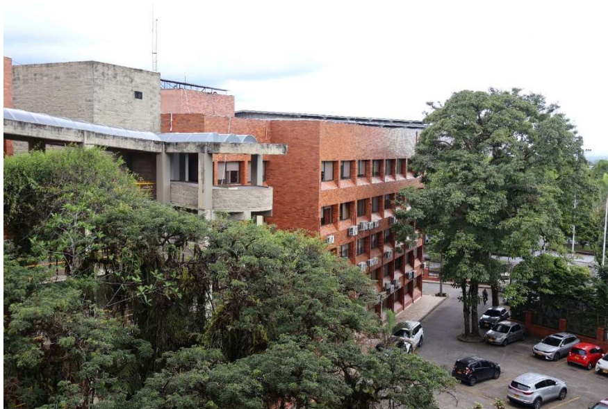
Ilustración 13. Fachada con presencia de individuos arbóreos.
