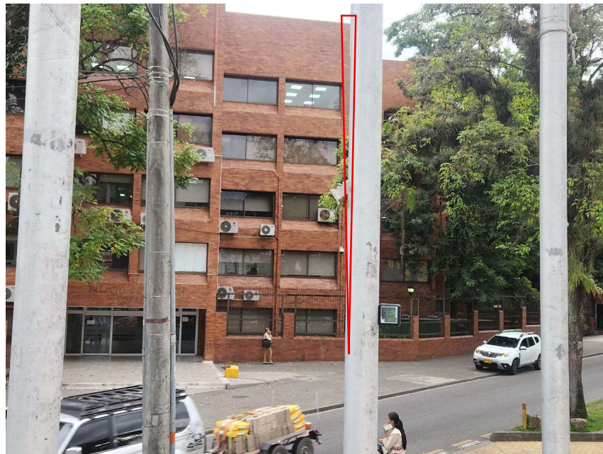
Ilustración 41. Inclinación presentado en la edificación.
