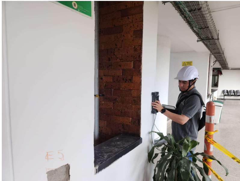
Ilustración 37. Procedimiento para detección de aceros de refuerzo con ferrosacan. (Fuente: Propia)
