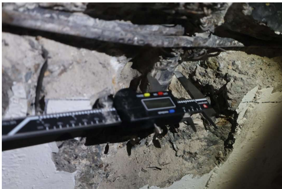
Ilustración 30. Procedimiento de Calas y/o Regatas para identificación de aceros de refuerzo acero corrugado. (Fuente: Propia)
