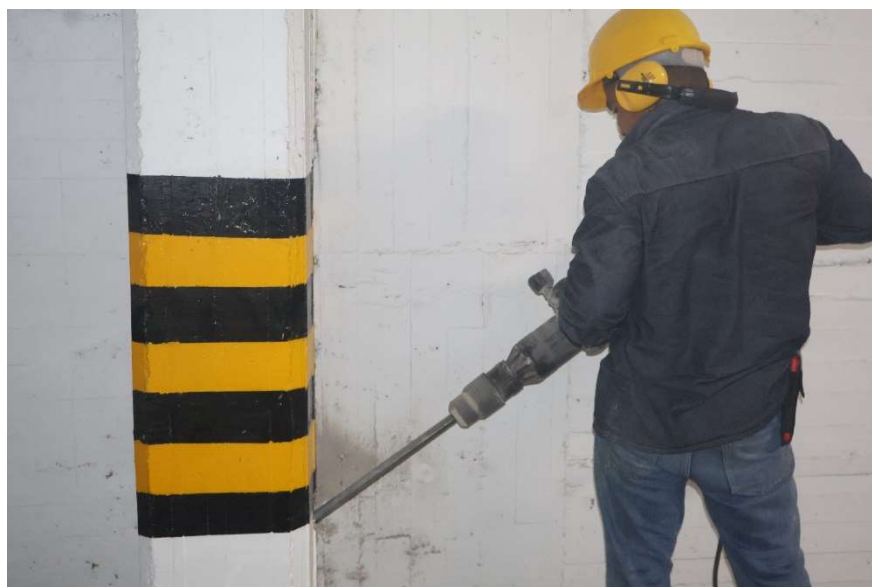
Ilustración 28. Procedimiento de Calas y/o Regatas para identificación de aceros de refuerzo. (Fuente: Propia)
