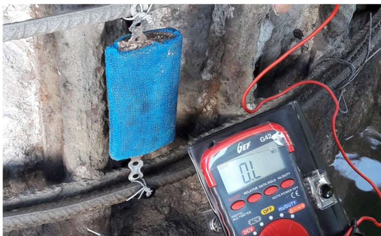
Ilustración 60. Instalación de ánodo de sacrificio en elemento de concreto reforzado (Fuente Novapox SL)
