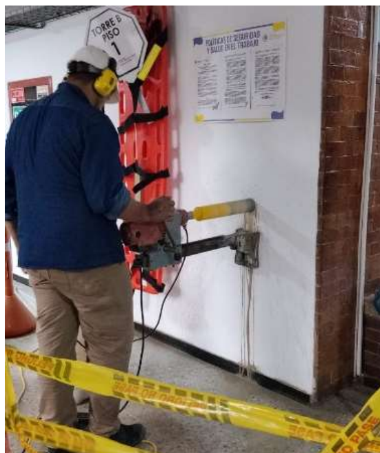
Ilustración 15. Procedimiento de extracción de núcleos en columna de concreto y ensayo de carbonatación. (Fuente: Propia)
