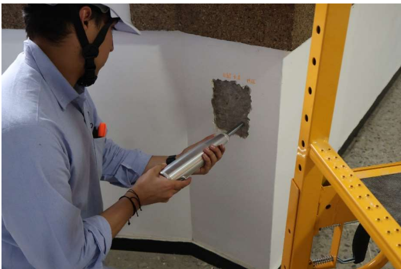
Ilustración 23. Procedimiento para ensayo de esclerometría a contrapunta en columna. (Fuente: Propia)
