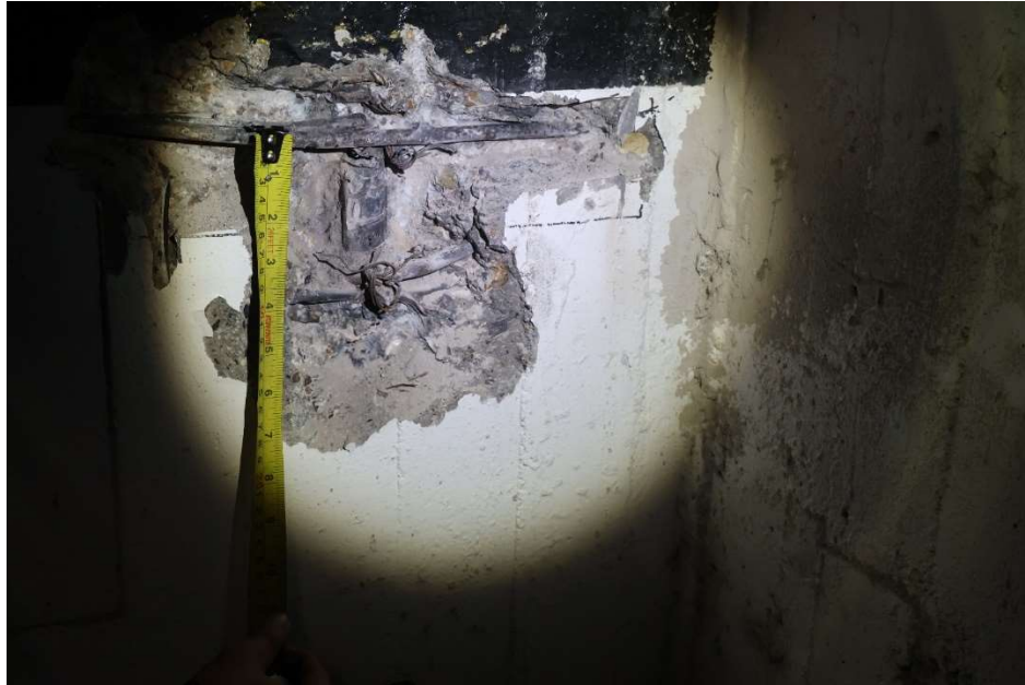
Ilustración 31. Procedimiento de Calas y/o Regatas para identificación de aceros de refuerzo. (Fuente: Propia)
