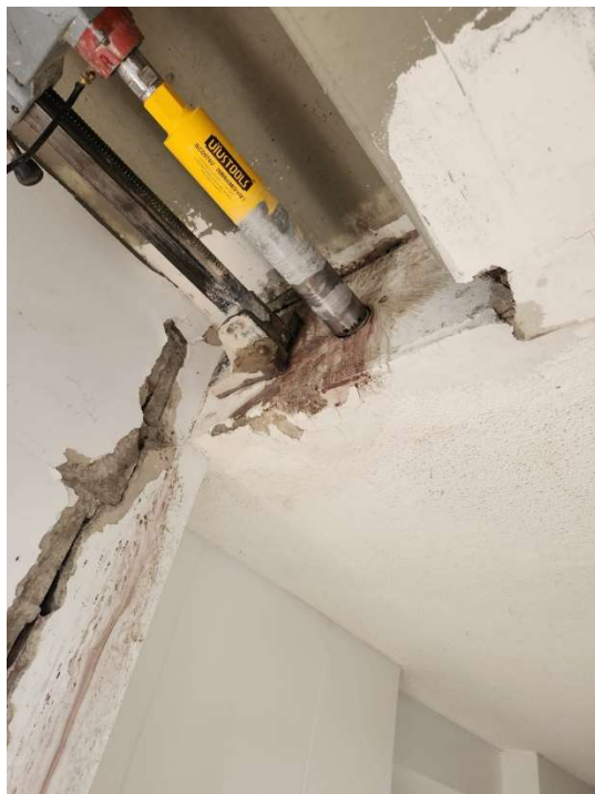
Ilustración 18. Procedimiento de extracción en vigas.. (Fuente: Propia)
