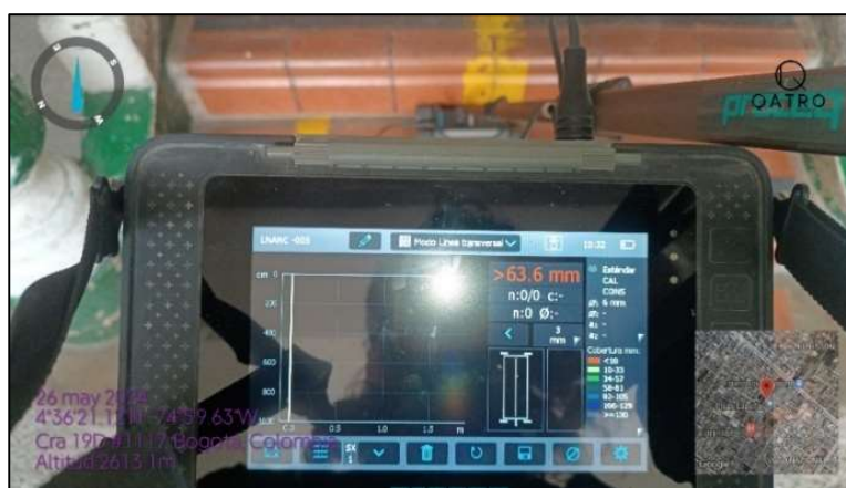
Ilustración 33. Procedimiento para detección de aceros de refuerzo con ferroskan. (Fuente: Propia)
