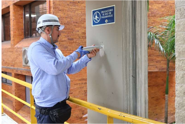
Ilustración 25. Procedimiento para ensayo de esclerometría. (Fuente: Propia)
