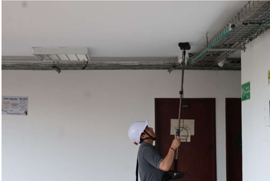
Ilustración 35. Procedimiento para detección de aceros de refuerzo con ferrosacan. (Fuente: Propia)
