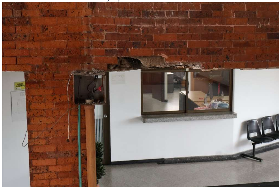
Ilustración 52. Ataque por corrosión en vigas.
