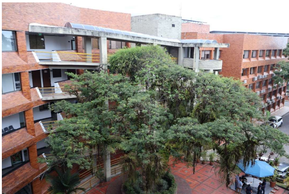
Ilustración 14. Fachada norte con presencia de individuos arbóreos frondosos.
