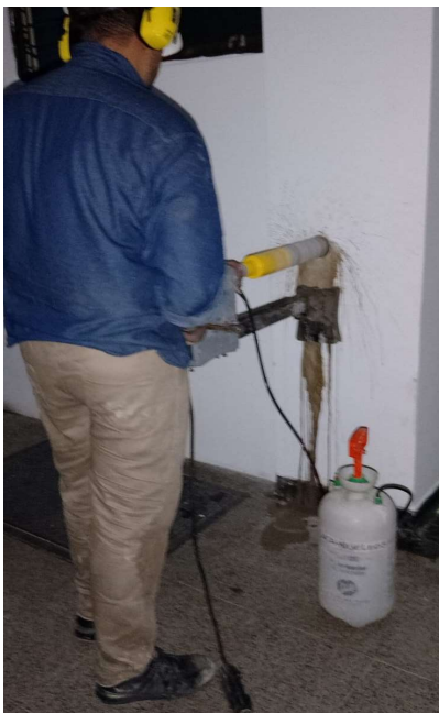
Ilustración 16. Procedimiento de extracción de núcleos en columna de concreto. (Fuente: Propia)
