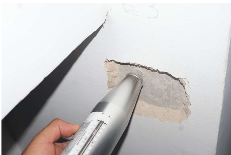
Ilustración 24. Procedimiento para ensayo de esclerometría a contrapunta en columna. (Fuente: Propia)
