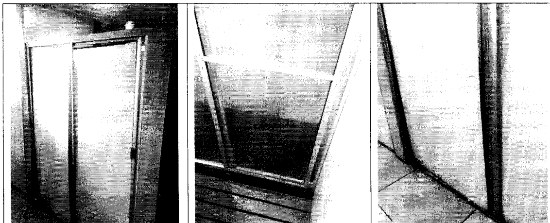
Suministro e instalación de divisiones en vidrio templado y aluminio, para duchas
