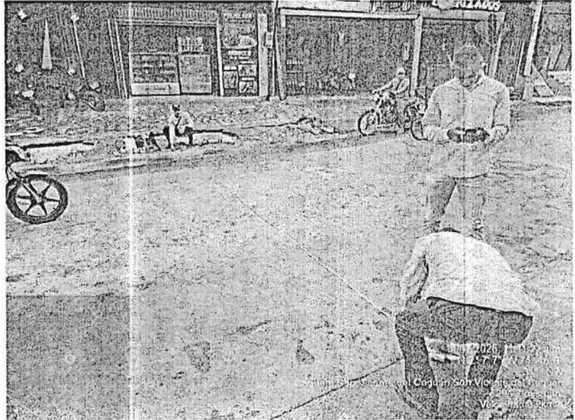
6 punto cruce PR 54+474 Entrada la comuna uno, 7.07 mts Ancho de vía
