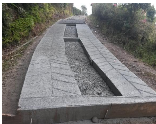
Fundición Franjas de Concreto
