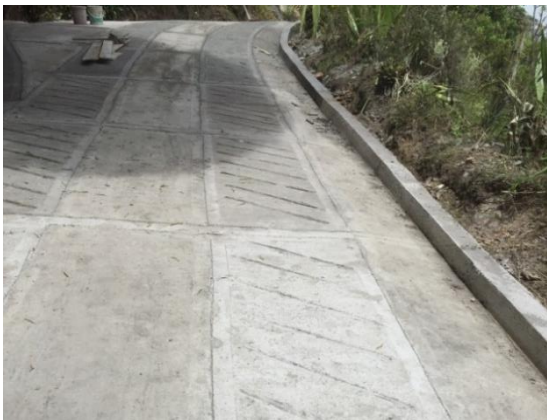
Fundición de Cunetas
