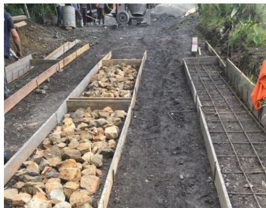
Fundición Franjas de Concreto
