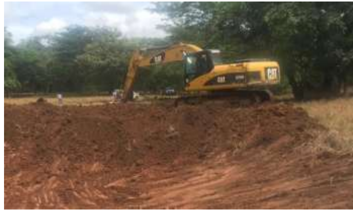
Corte y adecuación (imagen de referencia)
