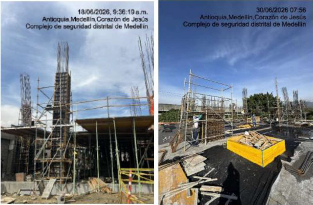
Colocación de refuerzo y formaleta para vaciado de columnas
