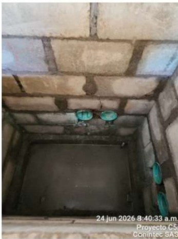
Cajas componente eléctrico
