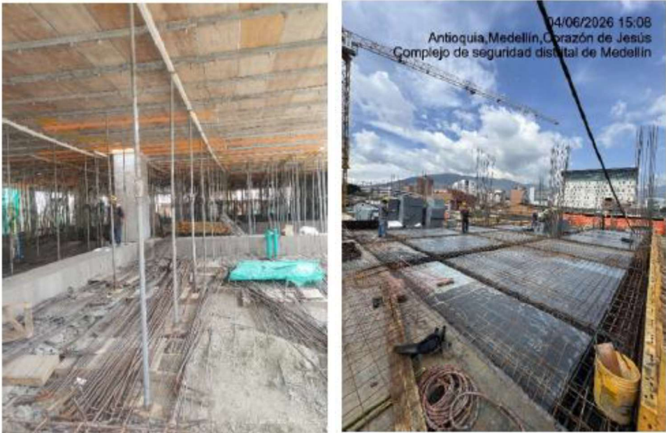
Obra falsa y colocación de malla Electrosoldada.
