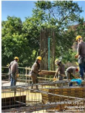
Instalación de tubería para bajantes de apantallamiento.
