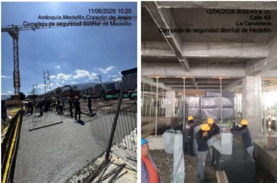
Vaciado y desencofrado de losa
