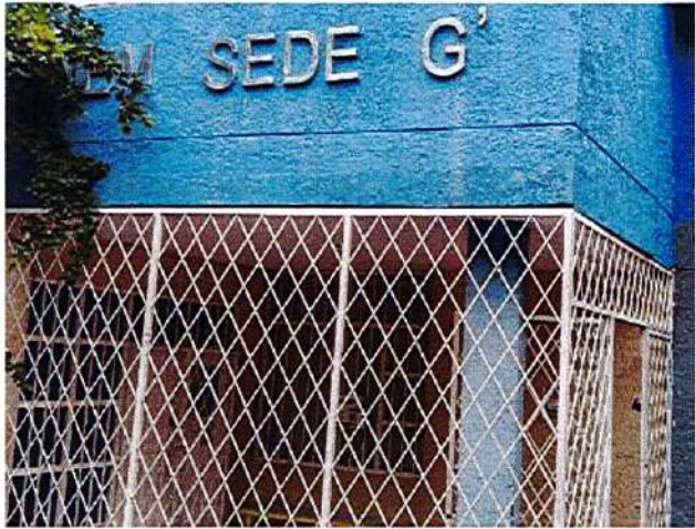
Condiciones locativas: Fachada Institución
