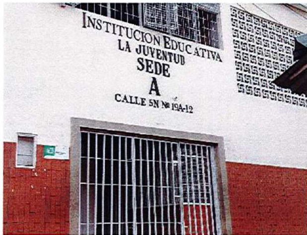
Condiciones locativas: Fachada Institución
