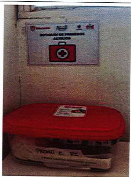
Seguridad y Salud en el trabajo - Botiquín
