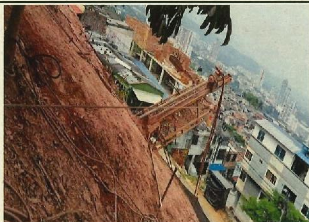
EQUIPOS DE PERFORACIÓN NEUMÁTICOS
