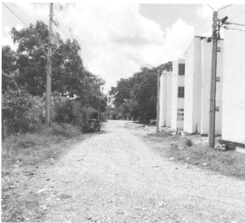
Ilustración 1 Estado actual de la Carrera 6 entre calles 14 y 16 de Hato Corozal, Casanare
