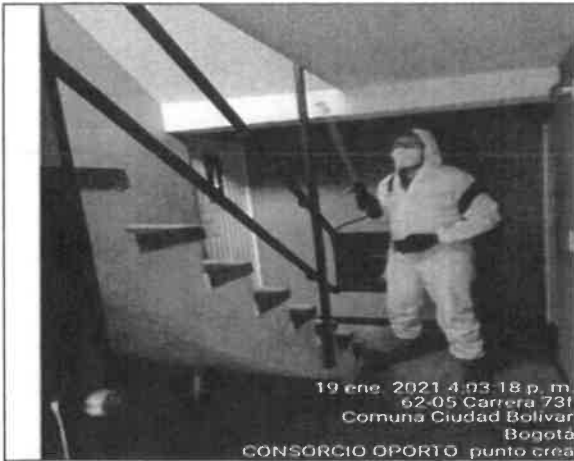
FOTO No. 5. Se evidencia ejecución de desinfección de las áreas del campamento de obra denominado PUNTO CREA, del contratista CONSORCIO OPORTO, a través de aspersión con AMONIO CUATERNARIO.
