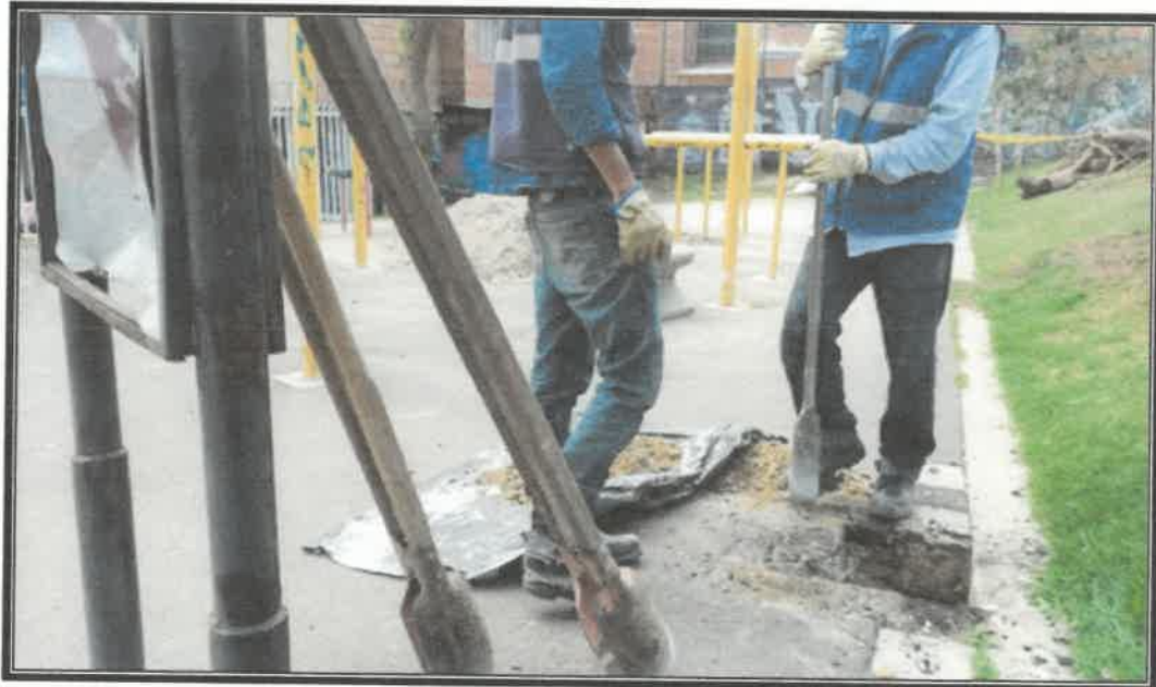
Ilustración No 4. Apiques realizados en el sitio parque código 19-031 Fuente: Consorcio Oporto.
