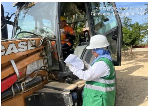
Foto 1. Inspección de dispositivos de emergencia
