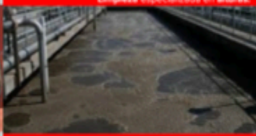
Bio-tratamiento de trampas de grasa. RILES
