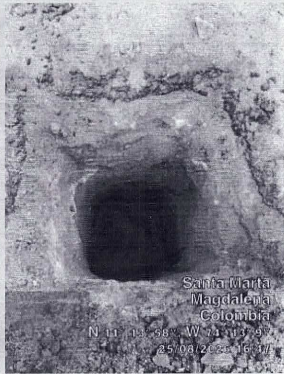
C-2. Detalle de excavación y material arenoso.
