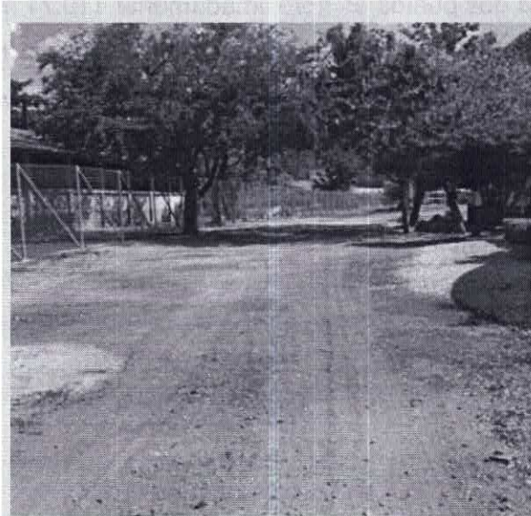
Vista general del corredor: superficie granular existente.
