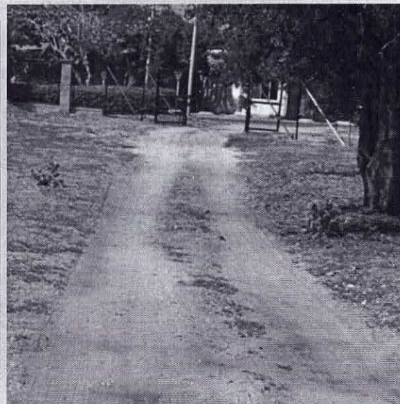
Vista del acceso y huellas de circulación sobre terreno granular.
