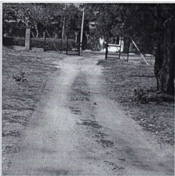
C-6. Huellas y acceso existente.
