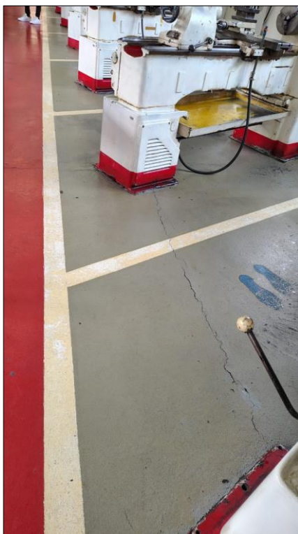
Fotografía 7. Fisuración piso vaciado bloque 18
