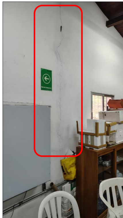
Fotografía 4. Fisuras en muros
