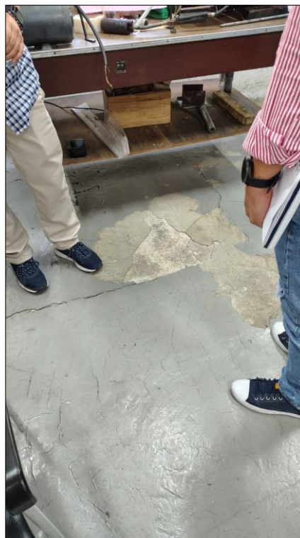
Fotografía 6. Fisuración y desprendimiento en acabado de piso bloque 16
