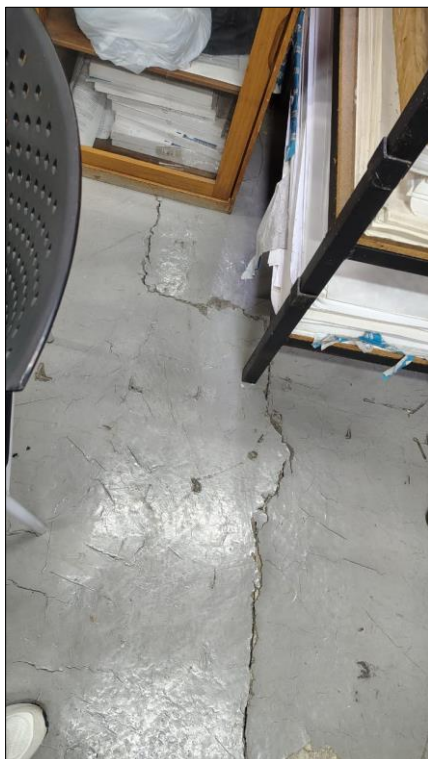
Fotografía 6. Fisuración y desprendimiento en acabado de piso bloque 16
