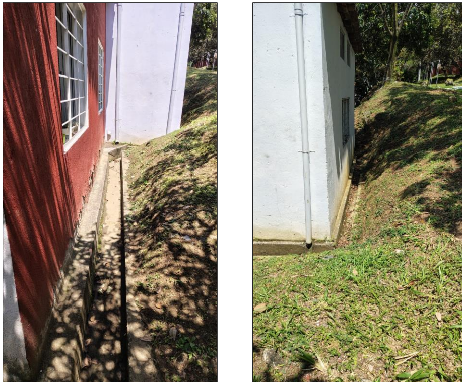
Fotografía 5. Cunetas en bloque 16
