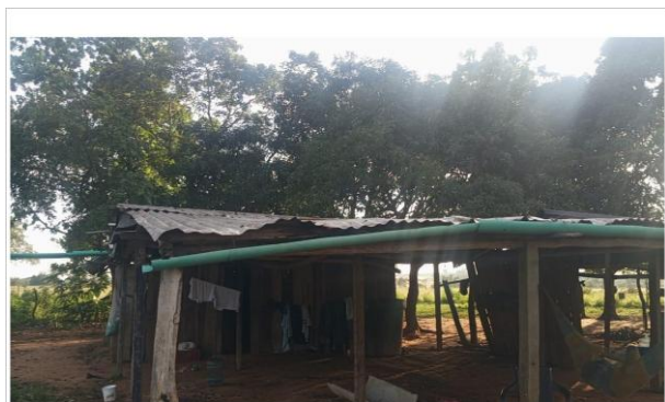
Fotografía 15. Estructura abierta con cubierta irregular y apoyos expuestos a la intemperie, con baja capacidad de aislamiento y protección del espacio interior.
