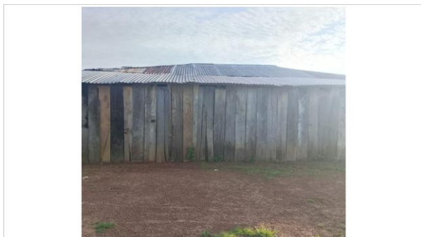
Fotografía 05. Vivienda en madera con cubierta metálica irregular, con desgaste acumulado y diferencias visibles entre los paños instalados.
