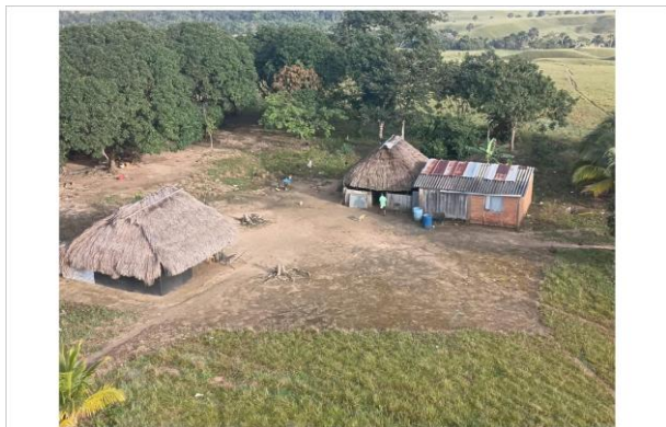
Fotografía 19. Vista aérea de un asentamiento que evidencia coexistencia de cubiertas en palma y lámina y diversidad en las soluciones habitacionales existentes.
