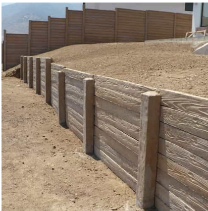
Muro de contención en madera
