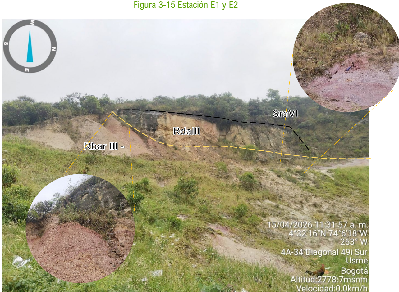
Figura 3-15 Estación E1 y E2
