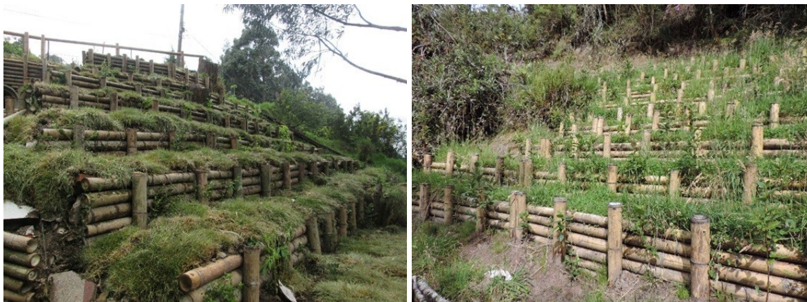
Figura 7-36 Imágenes de referencia obra complementaria trincho en madera
