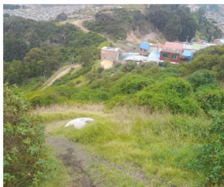
Fotografía 4. Vista aguas abajo vía afectada
