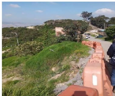
Fotografía 2. Parte superior talud vial
