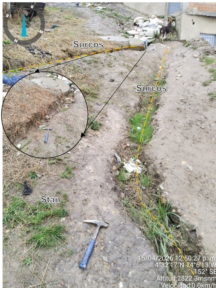
Figura 3-52 Surcos generados por escorrentías
