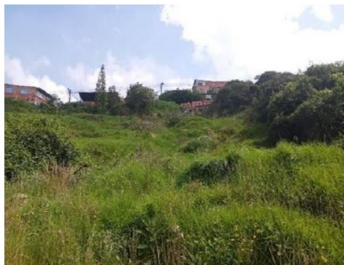
Fotografía 1. Parte inferior talud vial
