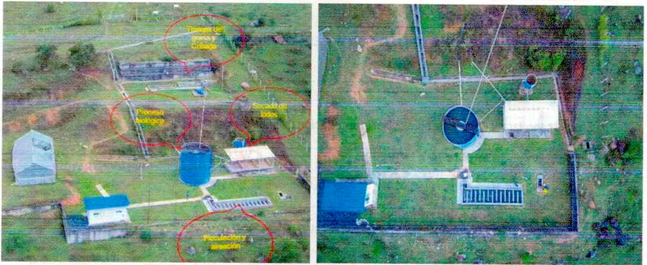
Figura 1. Estado de la Planta de tratamiento de aguas residuales (PTAR).
