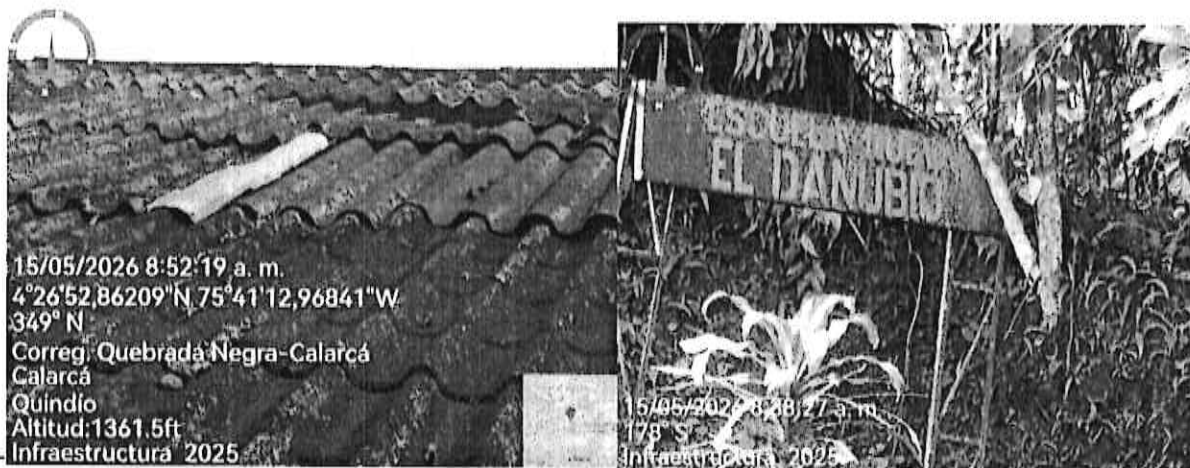
Cubierta en teja fibro-cemento tipo española
