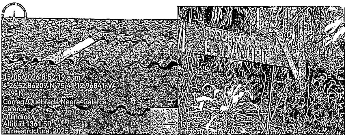
Cubierta en teja fibro-cemento tipo española
