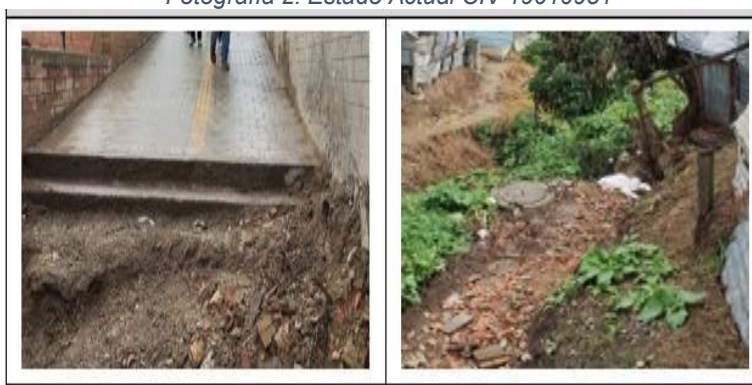
Fotografía 2. Estado Actual CIV 19010951
