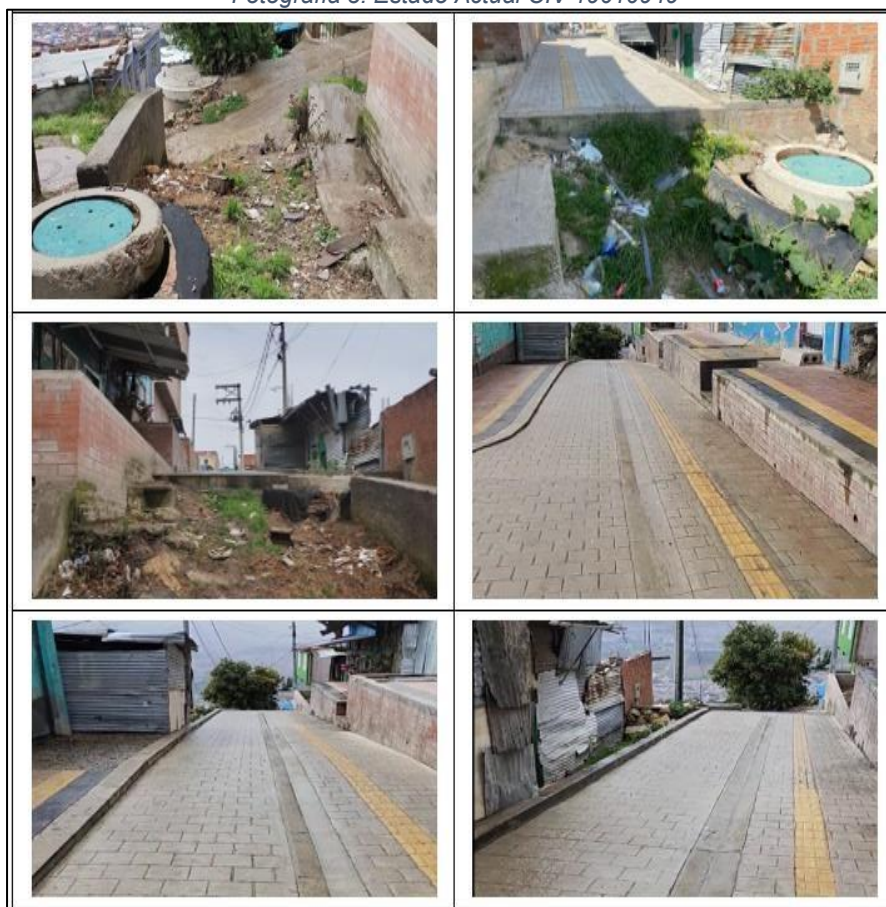
Fotografía 3. Estado Actual CIV 19010949
