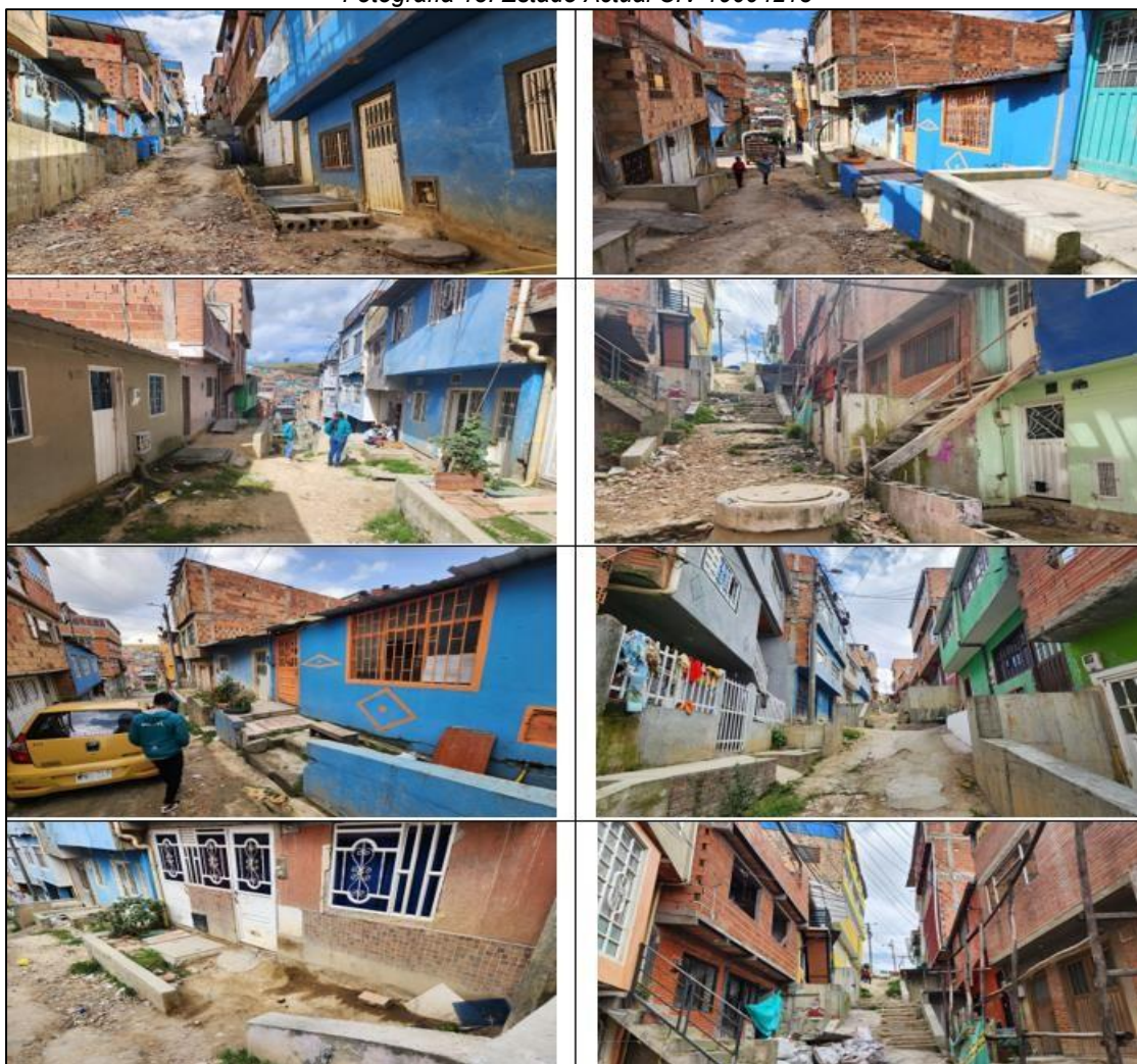
Fotografía 13. Estado Actual CIV 19004213
