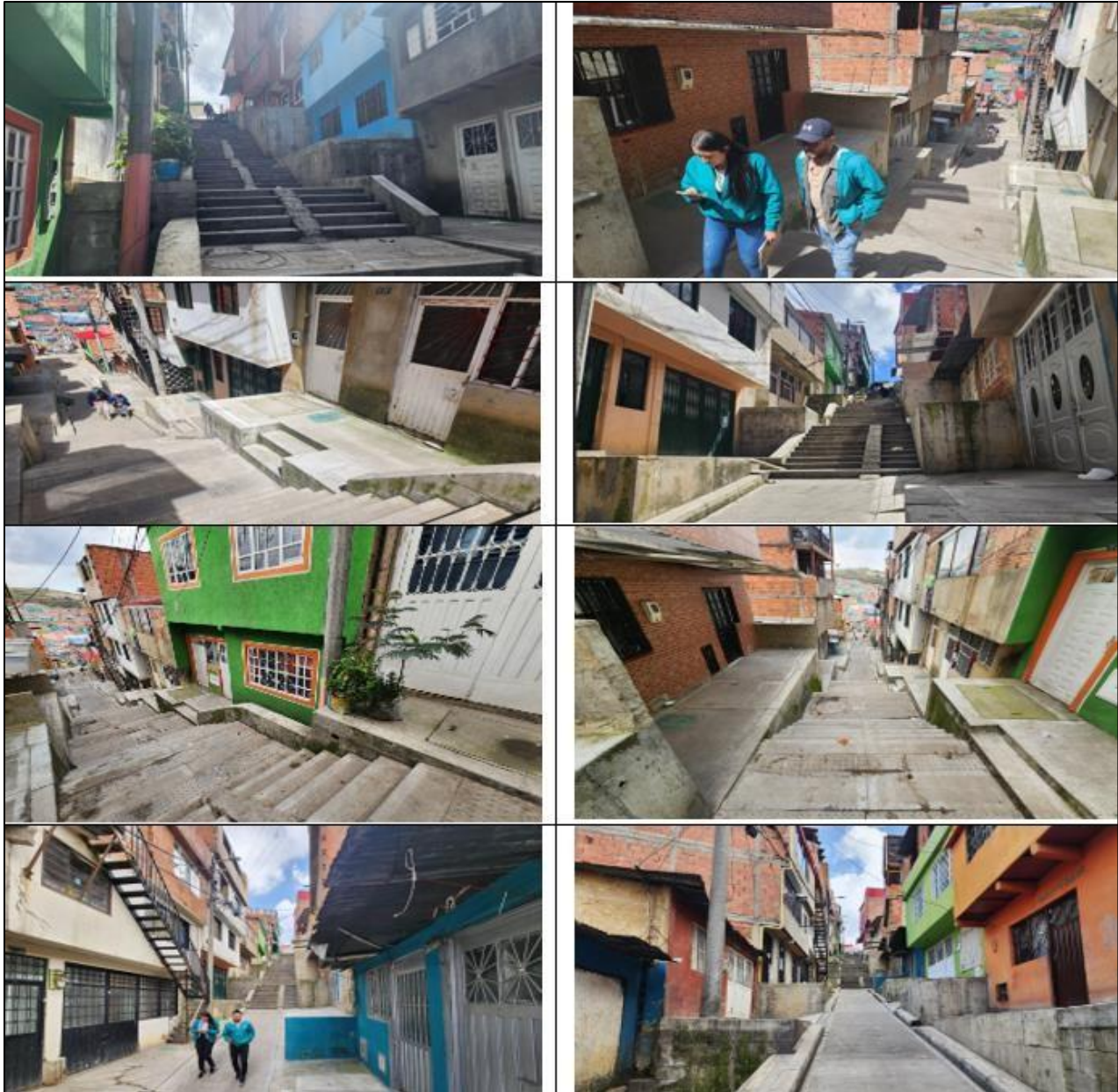
Fotografía 12 Estado Actual CIV 19004172
