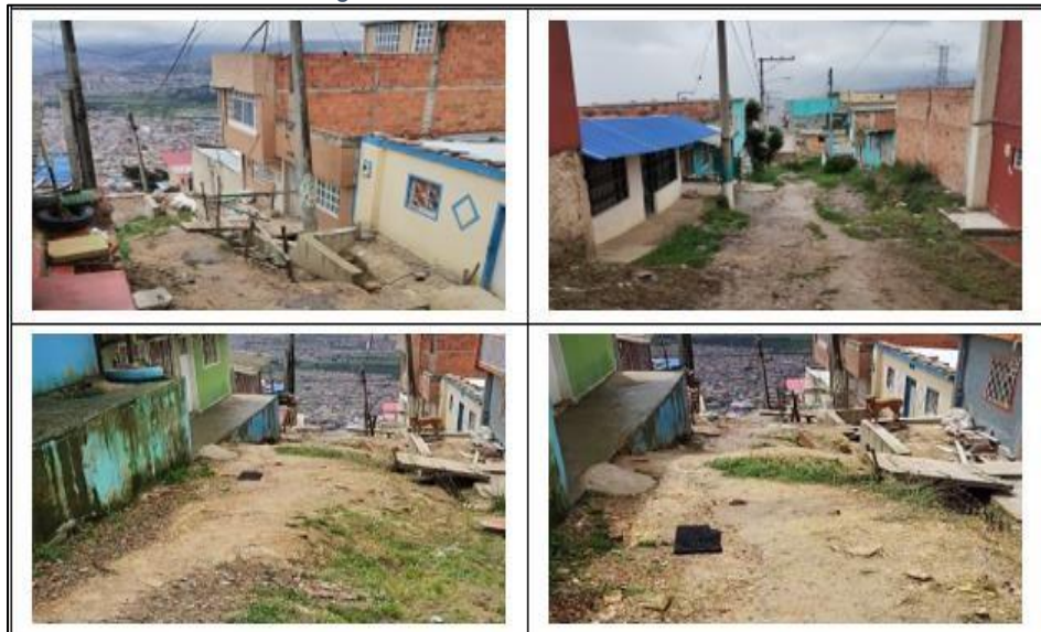
Fotografía 8. Estado Actual CIV 19010555
