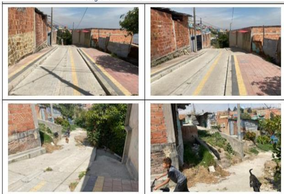
Fotografía 4. Estado Actual CIV 19011016
