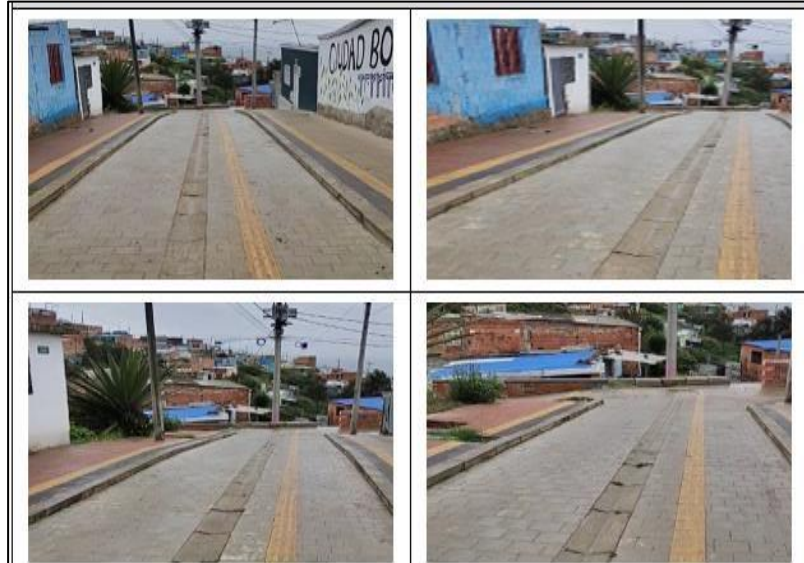
Fotografía 1. Estado Actual CIV 19011027
