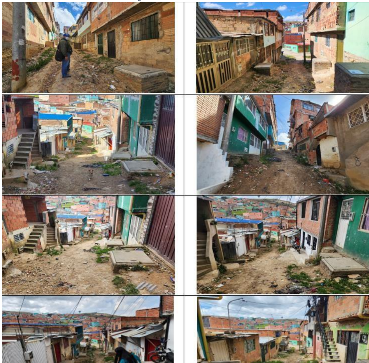
Fotografía 16. Estado Actual CIV 19004334
