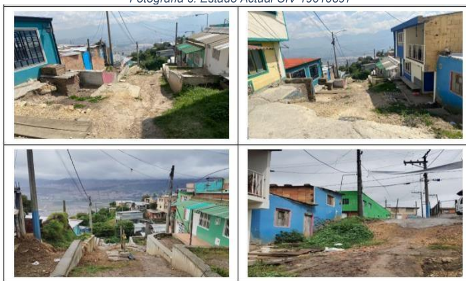
Fotografía 6. Estado Actual CIV 19010897
