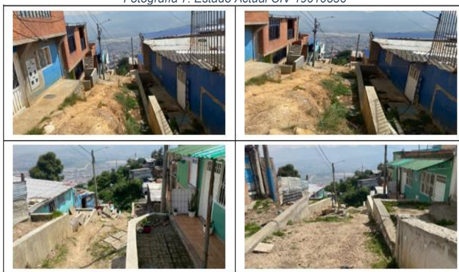
Fotografía 7. Estado Actual CIV 19010836
