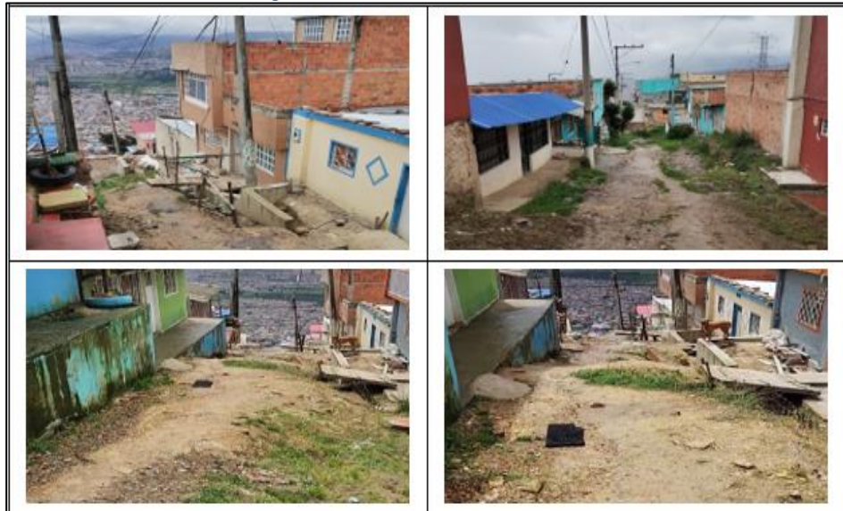
Fotografía 8. Estado Actual CIV 19010555
