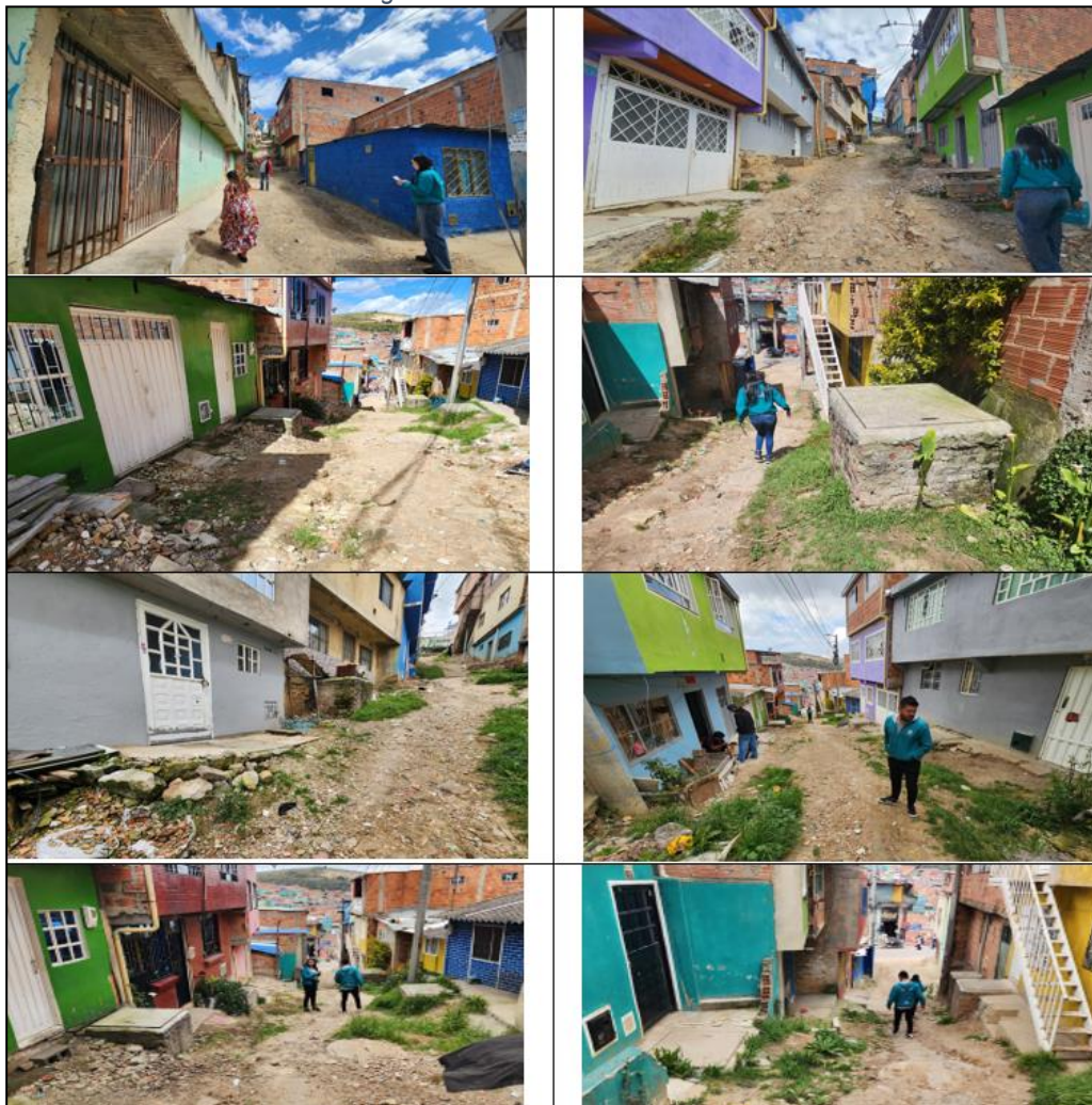
Fotografía 11 Estado Actual CIV 19004130
