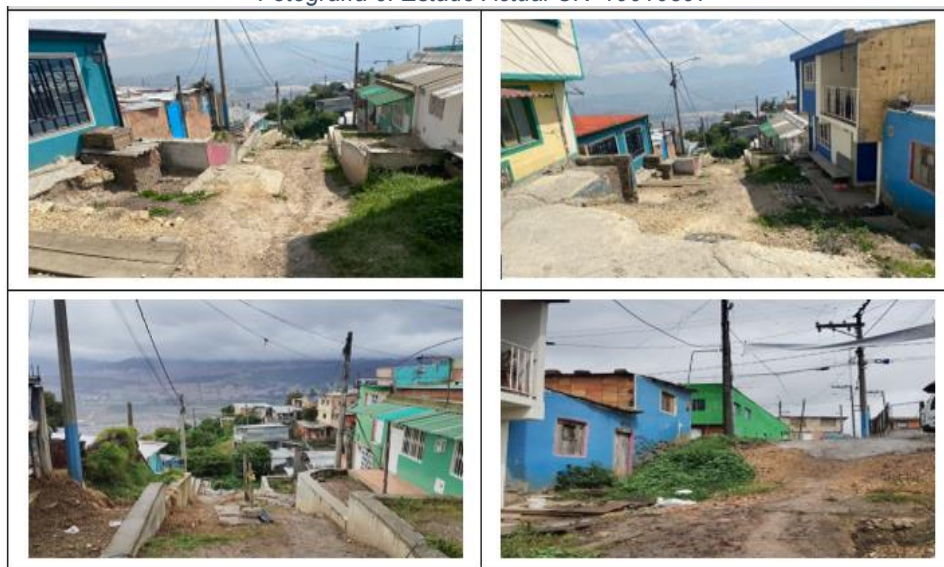
Fotografía 6. Estado Actual CIV 19010897
