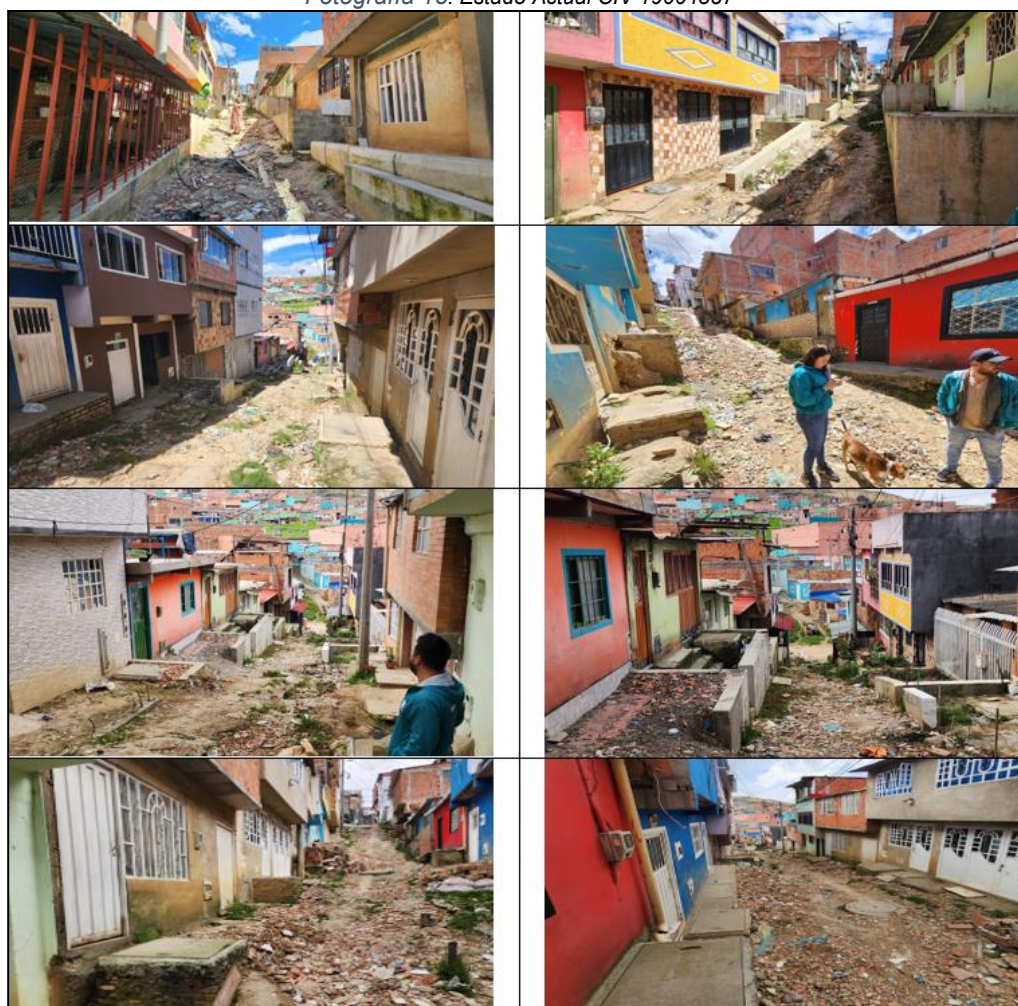
Fotografía 15. Estado Actual CIV 19004387
