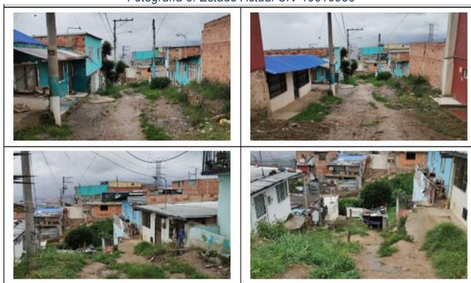
Fotografía 5. Estado Actual CIV 19010956
