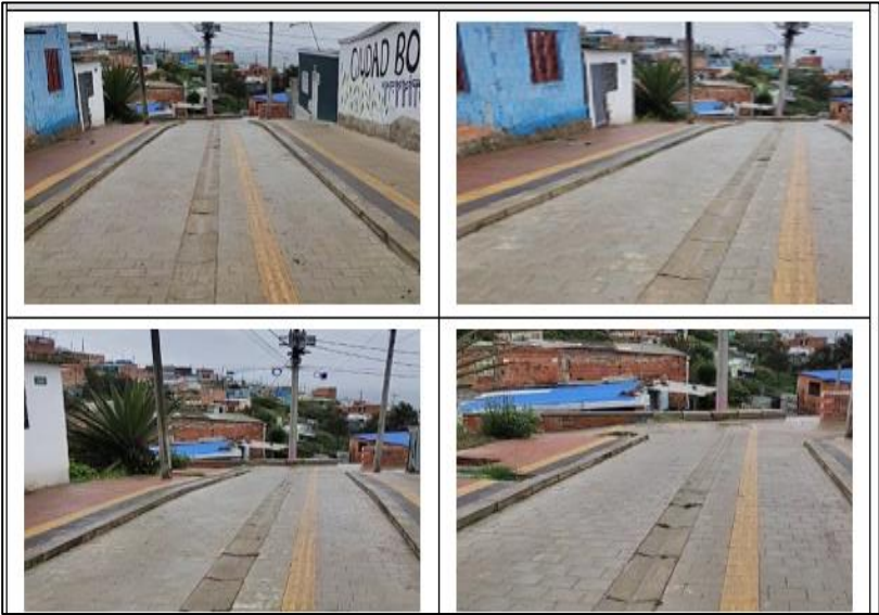
Fotografía 1. Estado Actual CIV 19011027
