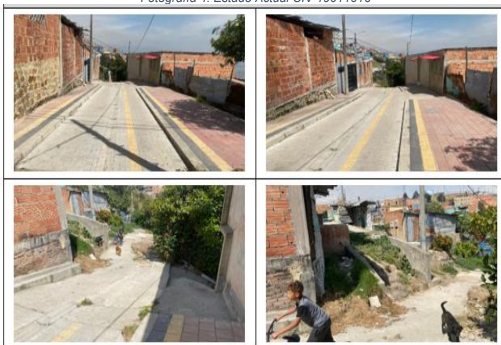
Fotografía 4. Estado Actual CIV 19011016
