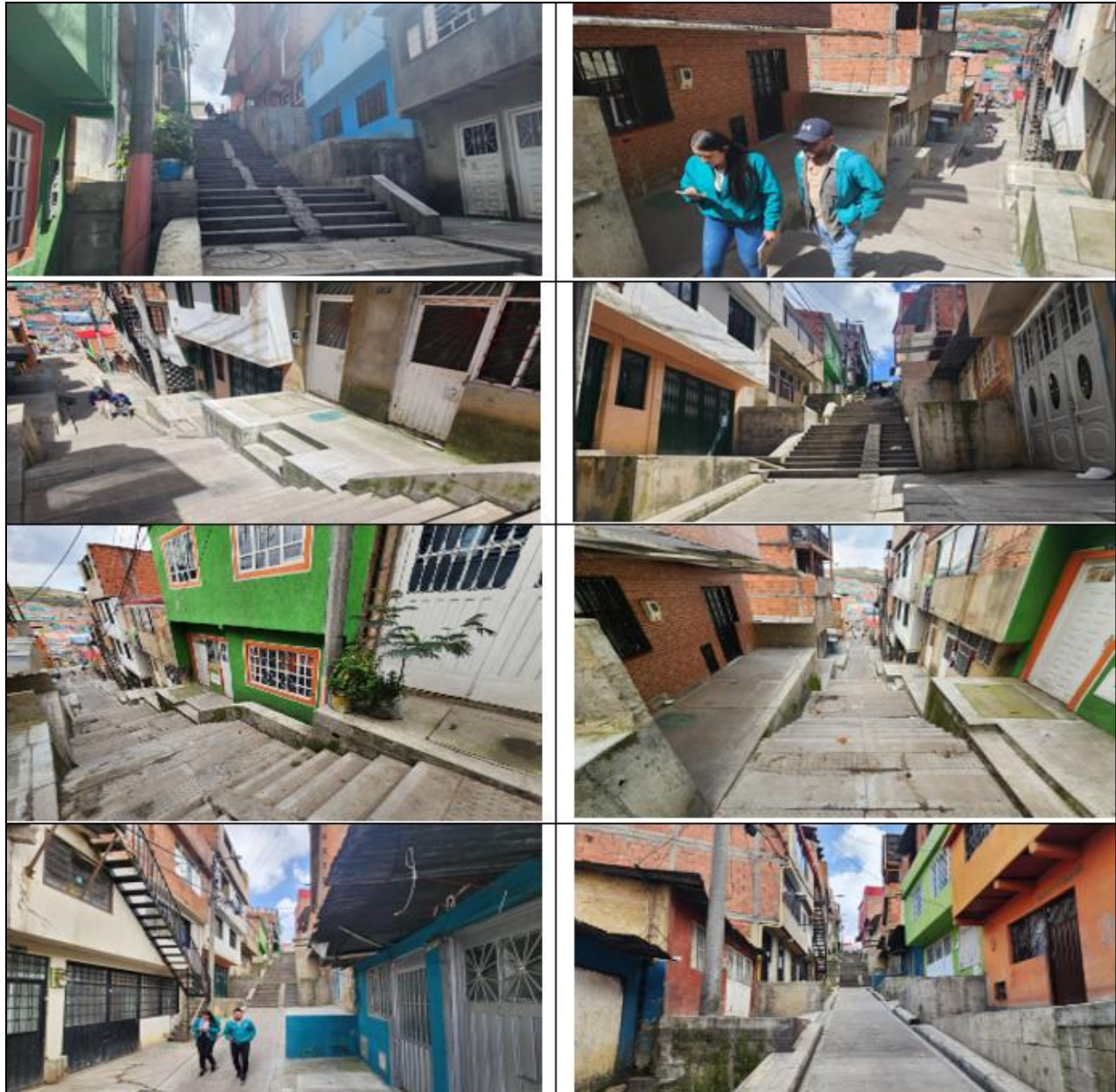
Fotografía 12 Estado Actual CIV 19004172
