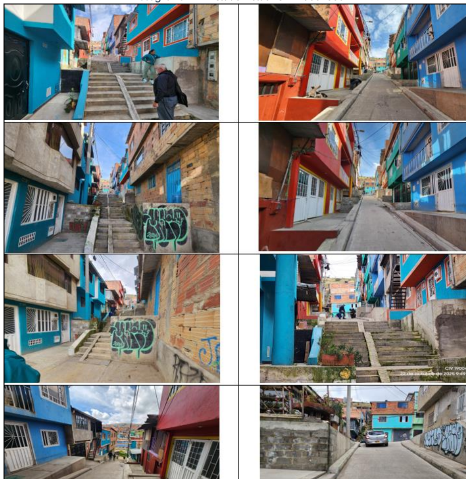
Fotografía 17. Estado Actual CIV 19004335
