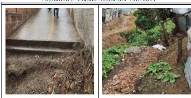
Fotografía 2. Estado Actual CIV 19010951
