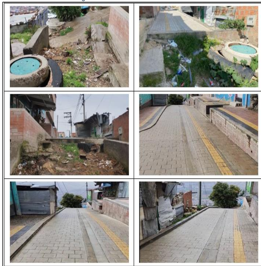
Fotografía 3. Estado Actual CIV 19010949
