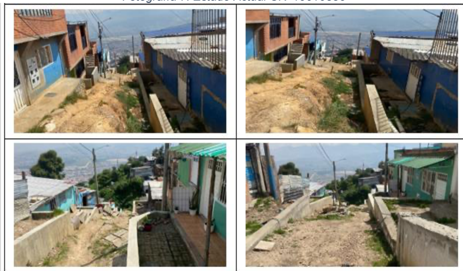
Fotografía 7. Estado Actual CIV 19010836
