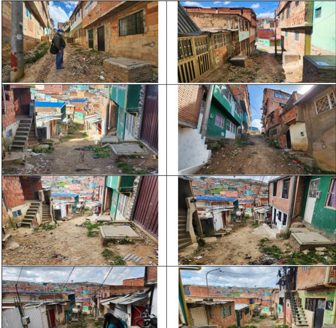
Fotografía 16. Estado Actual CIV 19004334
