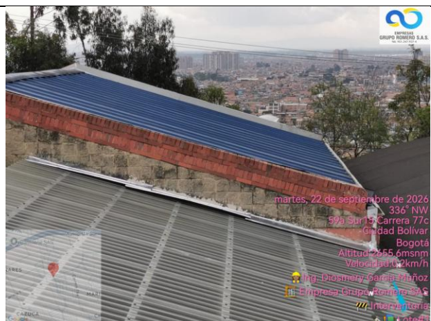
Instalación de flanches.
