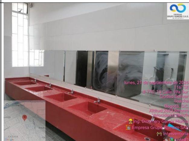
Instalación de grifería en todos los lavamanos en policuarzo
