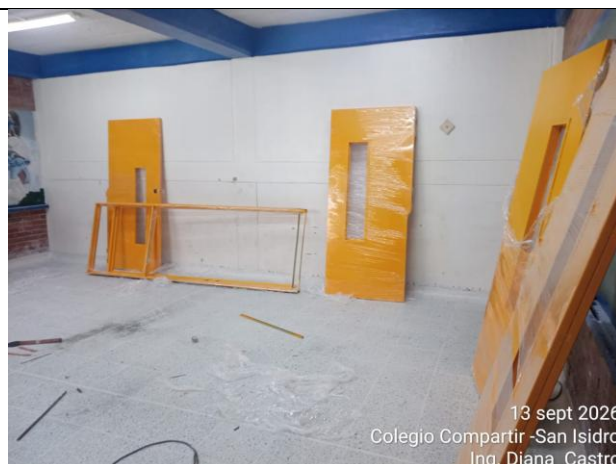
Extensión de mediacaña en aula #4 y pintura en puertas para posterior instalación
