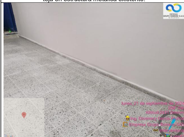
Instalación de guardascoba en piso de granito de 33*33
