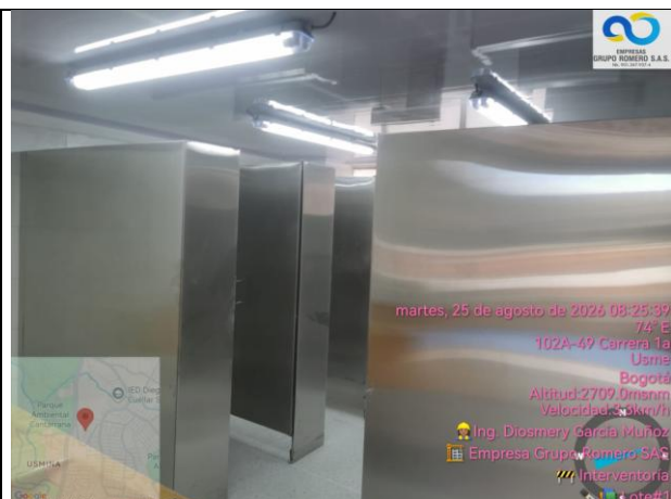
Actividad de Instalación de divisiones en acero inoxidable en baños de niños y niñas.
