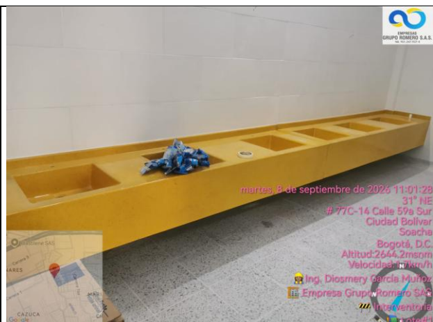
Se realiza instalación de lavamanos en policuarzo, baños de niñas planta #1 y #2.
