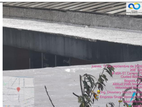
Instalación de socos en las diferentes áreas requeridas.
