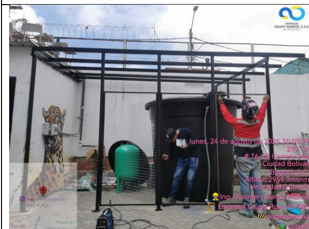
Instalacion de estructura metalica para cerrameinto
