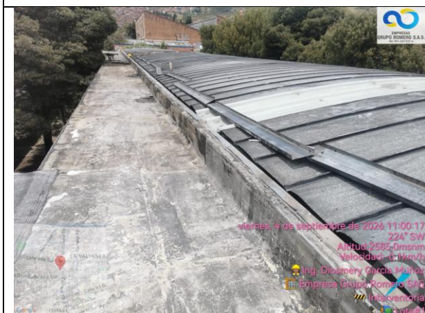
Retiro de manto asfáltico bloque naranja
