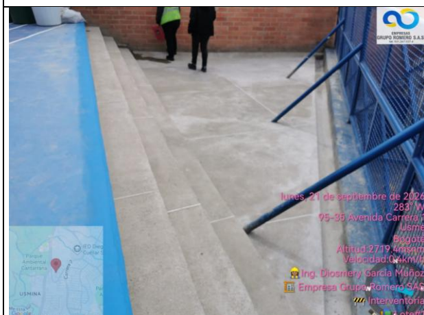
Terminación de actividad de extendida de gravilla mona lavada en nivel #3 y escalones.
