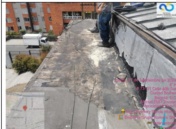
Se inician actividades en el nuevo tramo frente a bloque naranja y verde, se inicia con actividad de retiro de manto asfáltico
