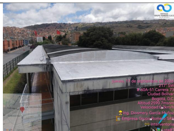
Terminación de instalación de manto de áreas del bloque verde donde se realiza pendiente de placa, aplicación de emulsión asfáltica, instalación de manto asfáltico, reinstalación de flanches, aplicación de pintura bituminosa e instalación de socos
