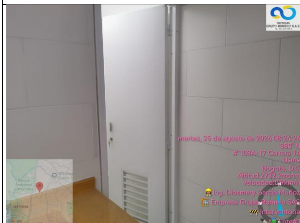
Suministro e instalación de puertas metálicas en baño de niñas.
