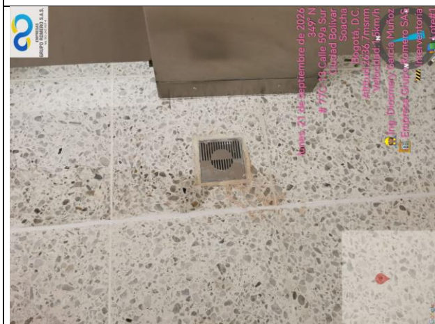
Instalación de rejillas de piso en los baños de la planta #2 (2un) y baños planta #1 (4un)
