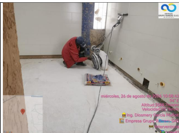
Se realiza pulimiento de piso en granito de 33*33
