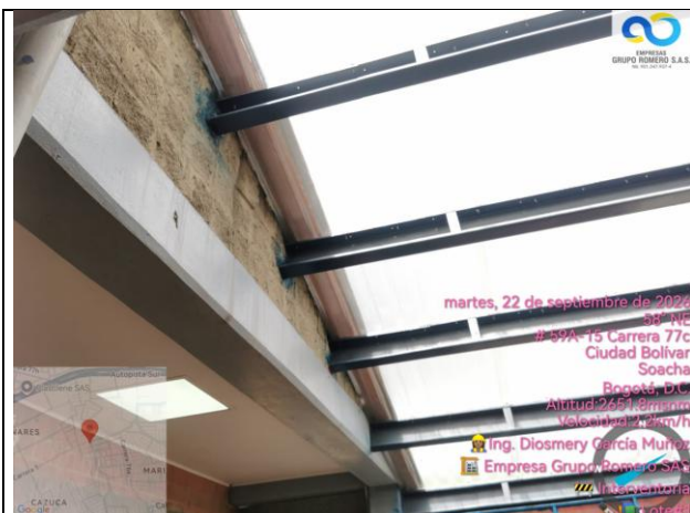
Instalación de Flanches en cubierta donde se hizo cambio de teja en estructura metálica existente.
