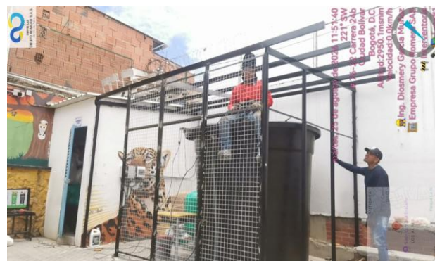
Suministro e instalación de malla electrosoldada para cerramiento.
