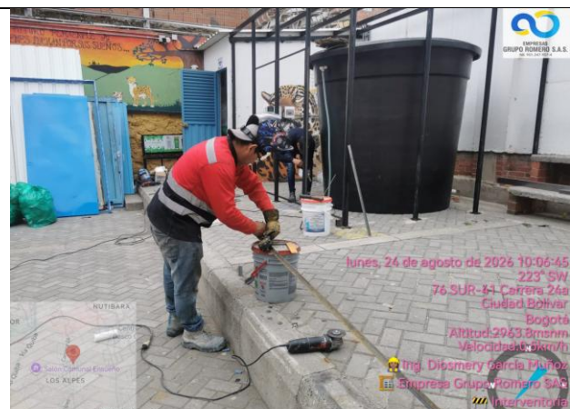
Construcción de cerramiento para tanque de almacenamiento y sistema hidroneumático.
