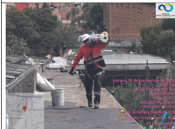
trasiego de manto asfáltico para posterior instalación.
