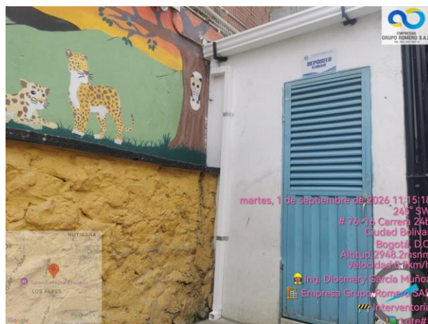
Instalación de bajantes para conducción de aguas lluvias.
