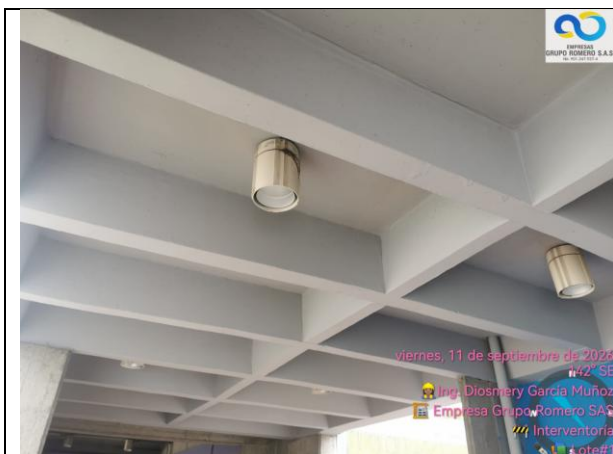
Se termina actividad de pintura bajo placa en pasillos de bloques naranja y morado
