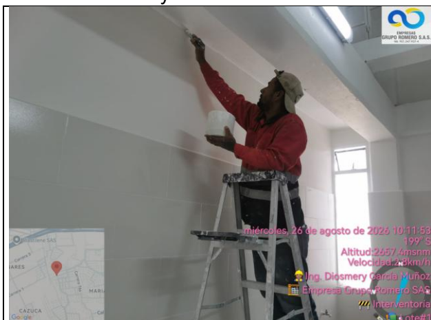
Actividad de detalles de pintura en los diferentes baños, planta #1 y #2
