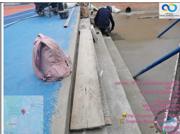
Inicio de instalación de perfilera metálica para cielo raso en el baño de niñas
