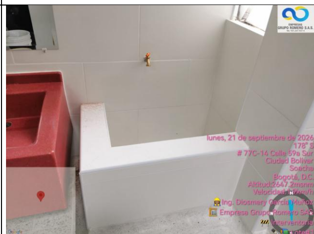
Instalación de llaves de jardín (3un)
