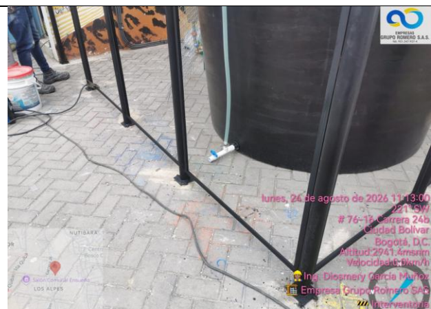
Aplicacion de anticorrosiv y pintura de estructura metalica
