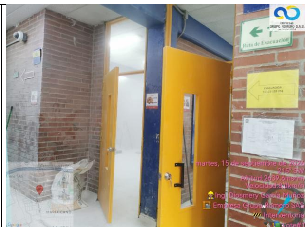
Instalación de puertas en aulas de la planta #1
