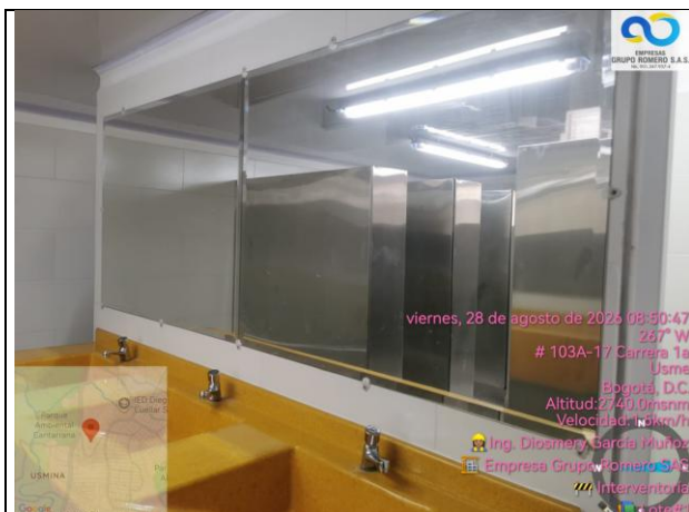
Instalación de espejos biselados en baño de niñas u niños arriba de lavamanos en policuarzo
