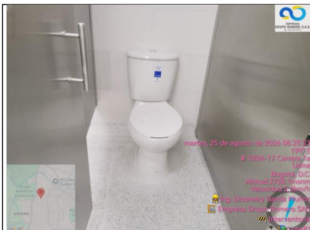
Instalacion de sanitarios en baños de niños y niñas
