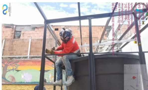
Soldadura en estructura metálica.
