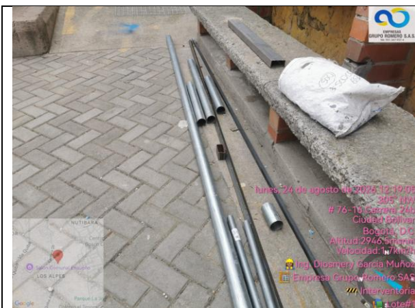
Suministro de materiales para construcción de cerramiento para tanque de almacenamiento y sistema hidroneumático.
