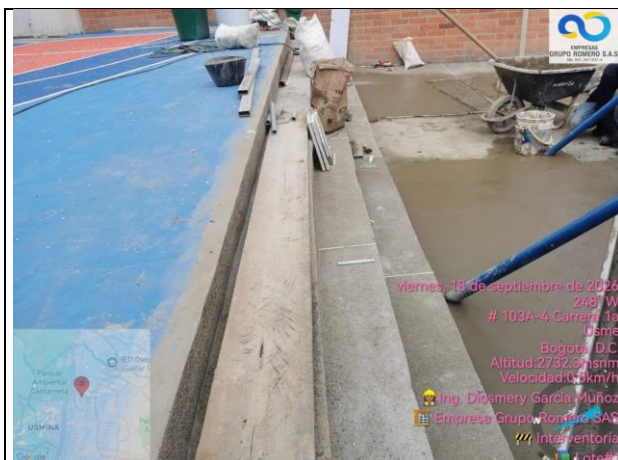
Terminación de instalación de piso en grano caucho en patio principal, nivel #1.
