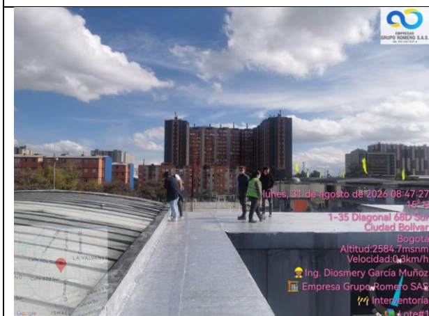
Se realiza recorrido de verificación de actividades terminadas en bloques azul y morado
