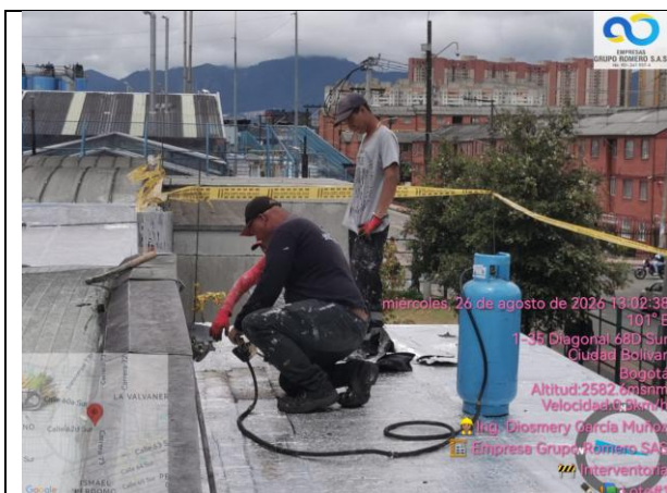
Se terminan actividades en bloque morado de instalación de manto asfáltico.
