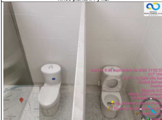
Se realiza instalación de sanitarios línea infantil
