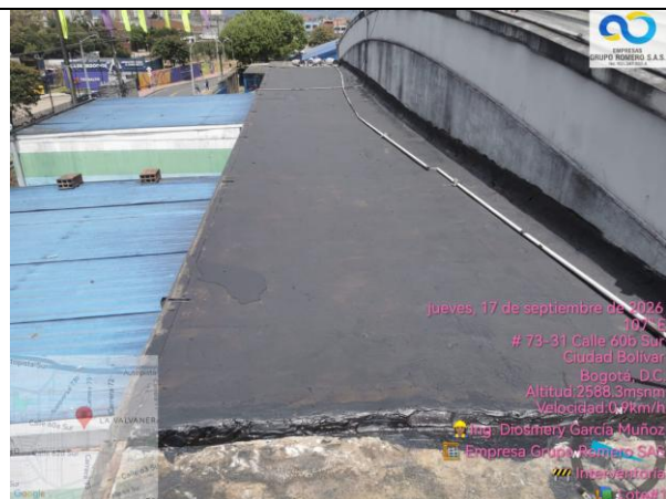
Aplicación de emulsión asfáltica en nuevo tramo para intervención.
