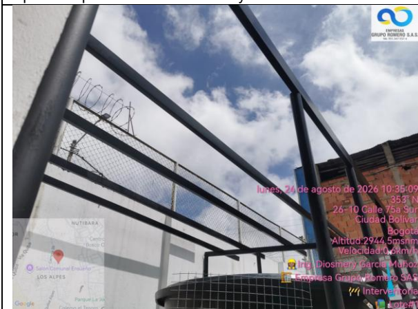
Instalacion de estructura metalica para cerrameinto
