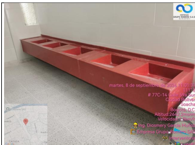
Se realiza instalación de lavamanos en policuarzo, baños de niños planta #1 y #2.
