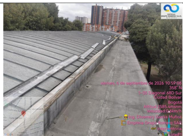
Desmonte de flanges existentes, bloque naranja.
