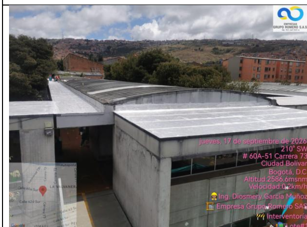
Terminación de instalación de manto de áreas del bloque naranja donde se realiza pendiente de placa, aplicación de emulsión asfáltica, instalación de manto asfáltico, reinstalación de flanches, aplicación de pintura bituminosa e instalación de socos
