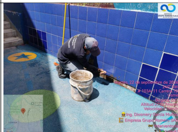
Actividad de aseo en la diferentes zonas intervenidas del patio principal.
