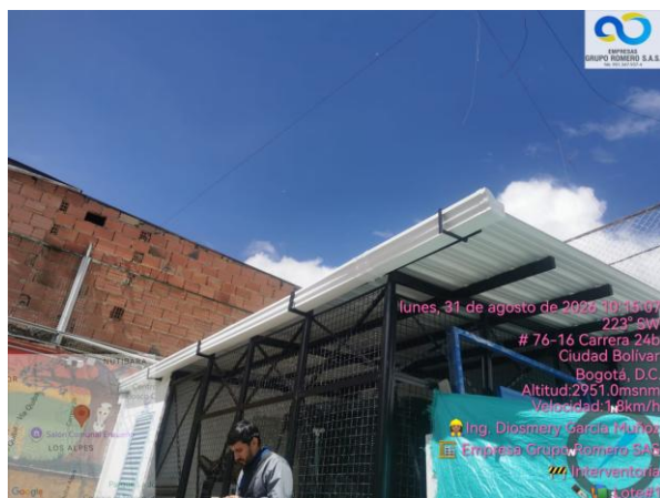
Instalación de canal plastica para conducción de aguas lluvias.
