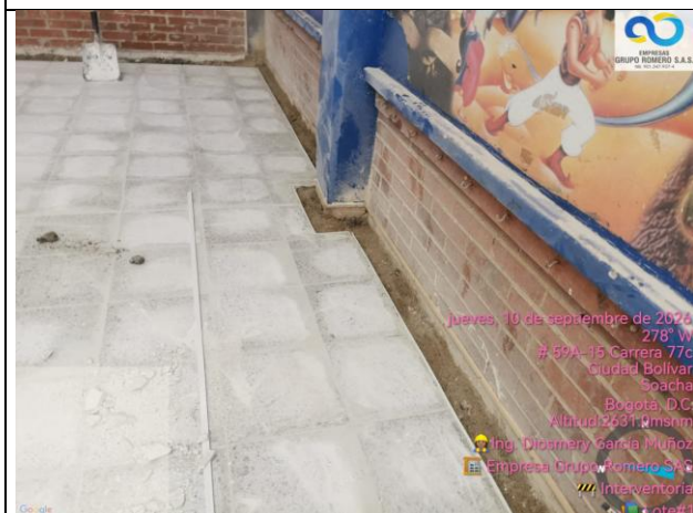
Alistado e instalación de piso en granito de 33*33 en el aula #4
