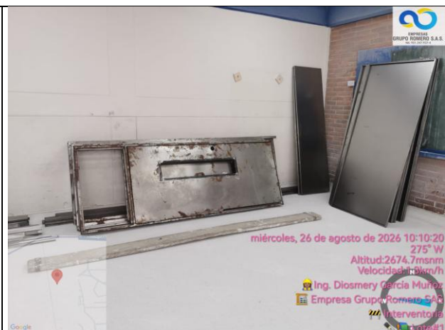
Se realiza actividad de fabricación de carpintería metálica "Puertas" en sitio.
