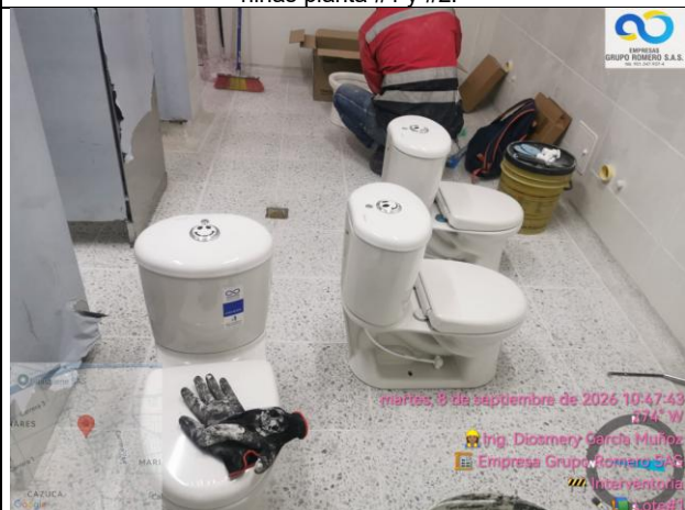
Se realiza instalación de sanitarios línea infantil
