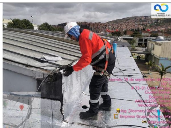
Instalación de manto asfáltico
