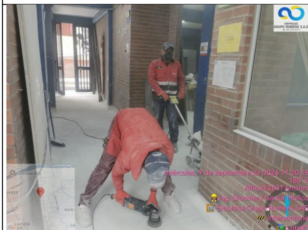
Brillo de piso en granito en pasillos
