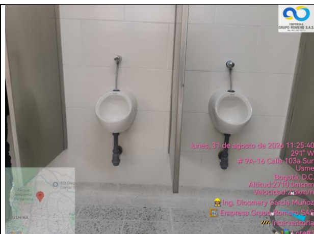
Suministro e instalación orinales baños de niños
