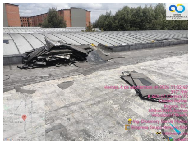
Se inicia actividad de retiro de manto asfáltico existente del bloque naranja
