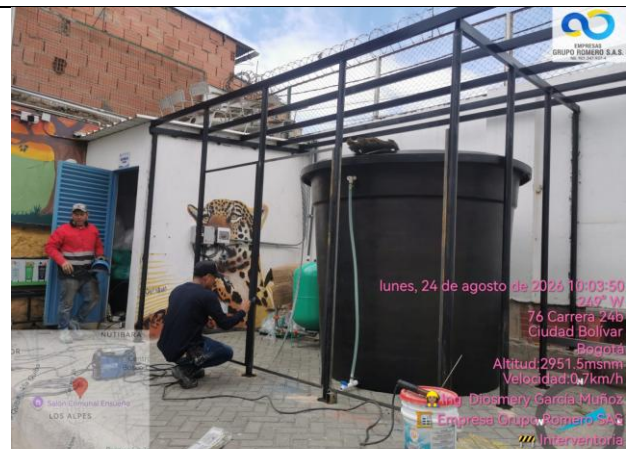
Aplicacion de anticorrosiv y pintura de estructura metalica
