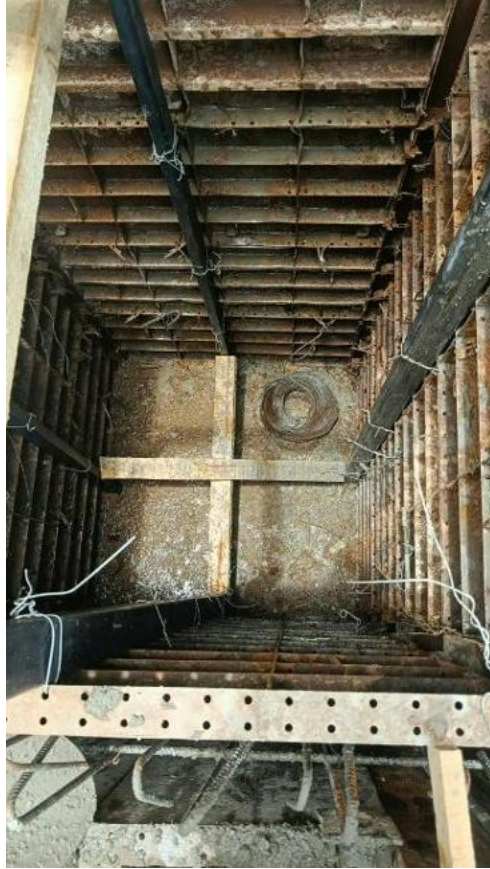
Figura 3. Armado del encofrado metálico interior de la poceta de la alcantarilla, previo a la fundición de muros.
