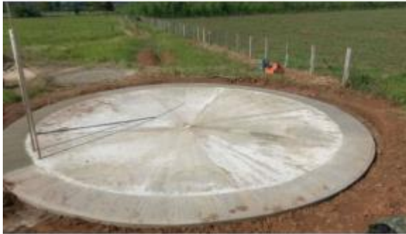
BASE EN CONCRETO
