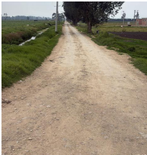
Imagen No. 13. Estado tramo siete. Fuente: Propia.
