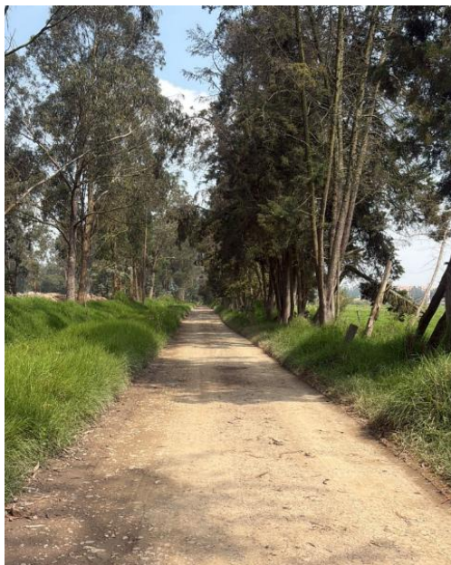
Imagen No. 15. Estado tramo nueve. Fuente: Propia.
