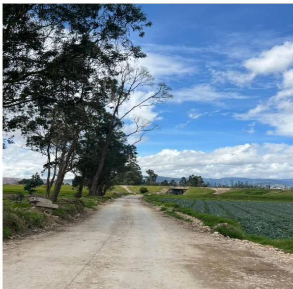
Imagen No. 6. Estado tramo tres. Fuente: Propia.
