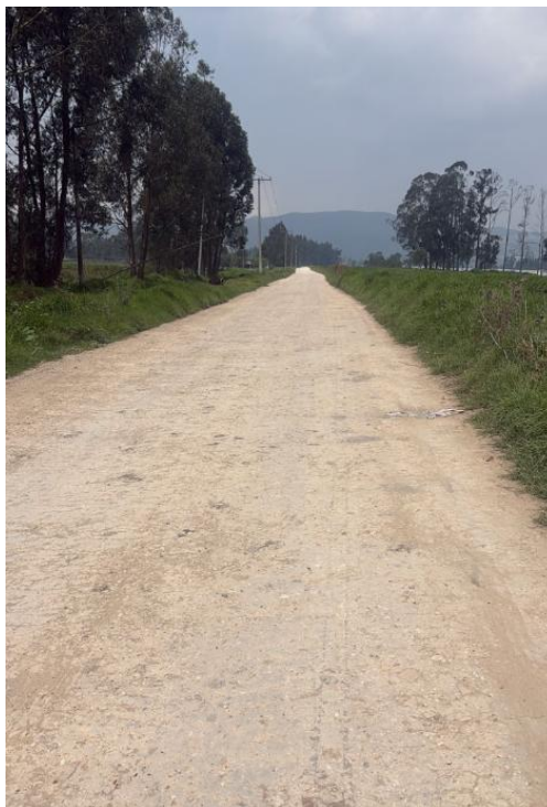
Imagen No. 17. Estado tramo once. Fuente: Propia.
