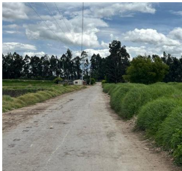
Imagen No. 2. Estado tramo uno. Fuente: Propia.
