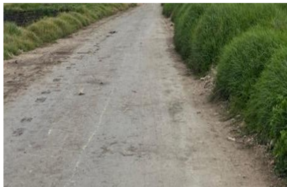
Imagen No. 4. Estado tramo dos. Fuente: Propia.
