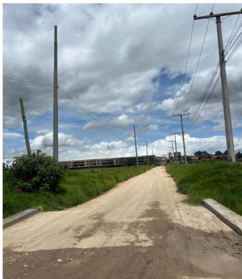
Imagen No. 8. Estado tramo cuatro. Fuente: Propia.
