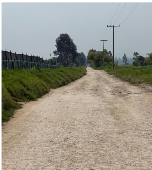
Imagen No. 19. Estado tramo trece. Fuente: Propia.
