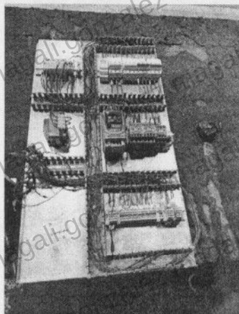
Fotografía 1. Tablero de control y potencia en proceso de cableado y preensamble en taller.
