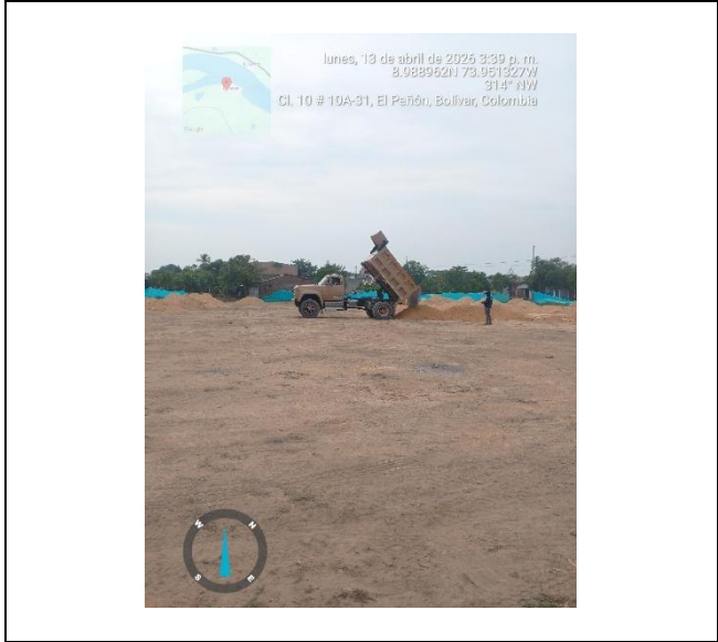
Colocación del material de relleno
