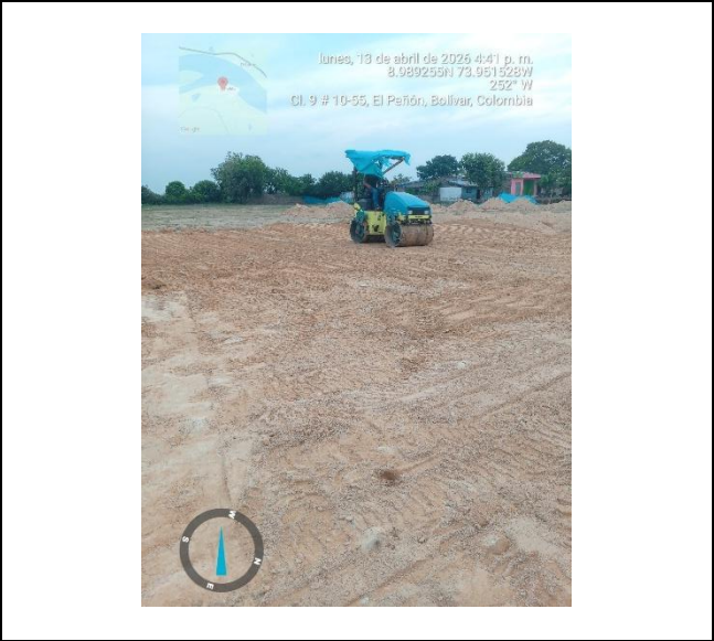
Compactación del material de relleno.
