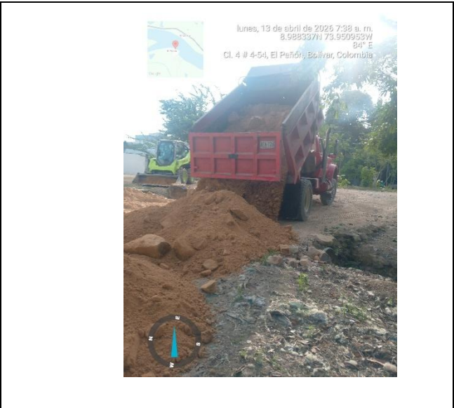
Relleno para mejoramiento de vía de acceso al predio
