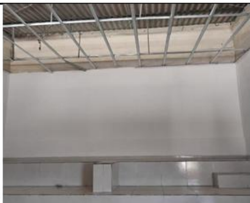
FOTO No 7 PINTURA DE AULAS EN SEGUNDO PISO IE SANTO DOMINGO SAVIO
