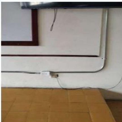
FOTO No 3 INSTALACIÓN DE REDES ELECTRICAS IE MALHABAR SEDE A - JOSÉ RUFINO
