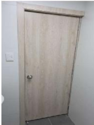
FOTO No1 INSTALACIÓN DE PUERTA DE BAÑO IE MALHABAR SEDE B – FRANCISCO GIRALDO
