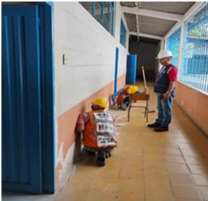
FOTO No1 PREPARACIÓN DE MUROS PARA PINTURA EN PASILLO IE SANTO DOMINGO SAVIO
