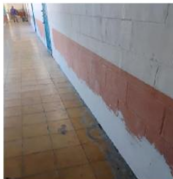
FOTO No 8 RESANE DE PASILLOS EN SEGUNDO PISO IE SANTO DOMINGO SAVIO
