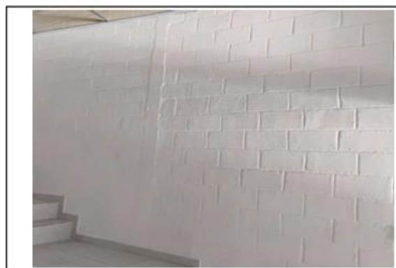
FOTO No 2 PINTURA DE MUROS DE AULAS IE DOMINGO SAVIO
