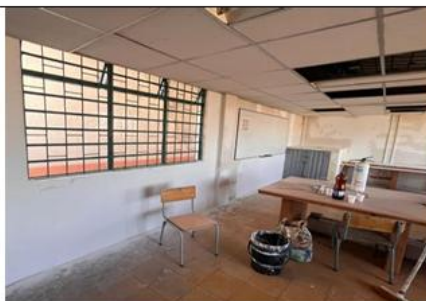
FOTO No 7 PREPARACIÓN DE MUROS EN AULA DE SISTEMAS IE SANTO DOMINGO SAVIO
