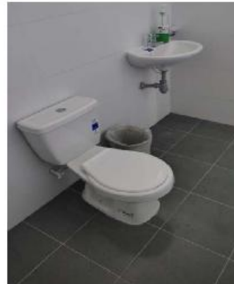
FOTO No 2 INSTALACIÓN DE APARATOS SANITARIOS IE MALHABAR SEDE B – FRANCISCO GIRALDO
