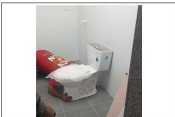
FOTO No1 INSTALACIÓN DE APARATOS SANITARIOS IE MALHABAR SEDE B – FRANCISCO GIRALDO
