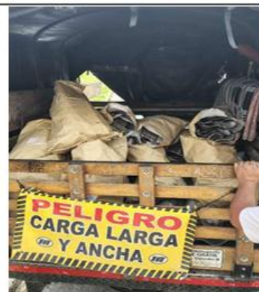
FOTO No 6 RETIRO DE ESCOMBROS IE MALHABAR SEDE PRINCIPAL
