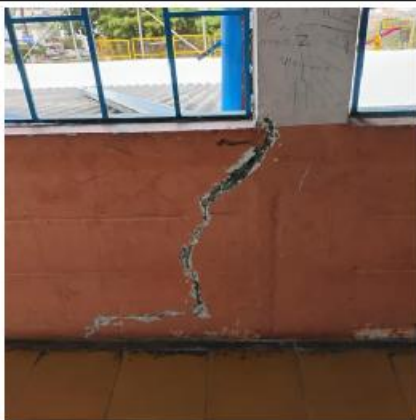
FOTO No 3 PREPARACIÓN DE MUROS PARA PINTURA IE SANTO DOMINGO SAVIO
