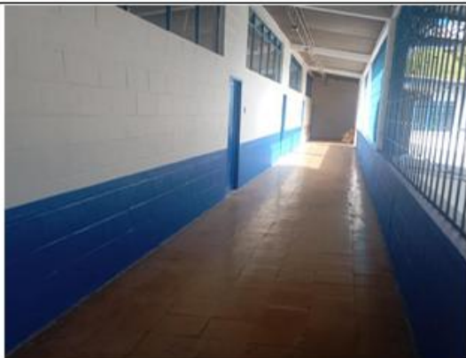
FOTO No 5 PINTURA DE PASILLOS EN SEGUNDO PISO IE SANTO DOMINGO SAVIO
