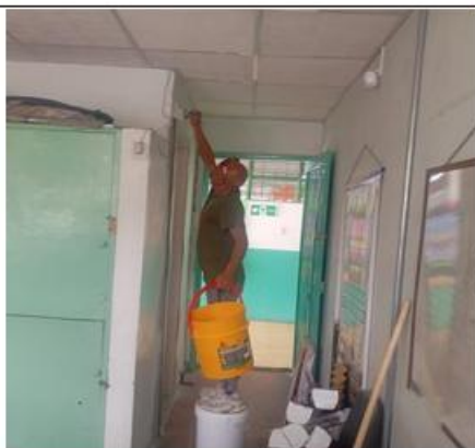
FOTO No1 PINTURA DE MURO INNGRESO A BAÑO IE MALHABAR SEDE B – FRANCISCO GIRALDO
