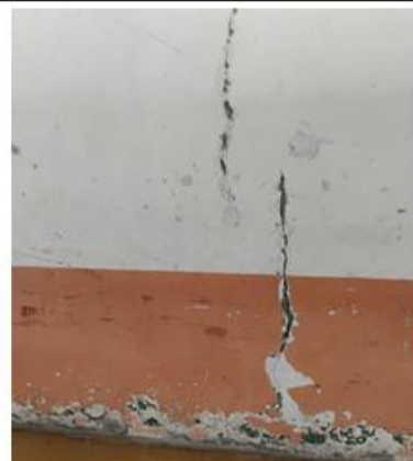
FOTO No 4 PREPARACIÓN DE MUROS PARA PINTURA IE SANTO DOMINGO SAVIO
