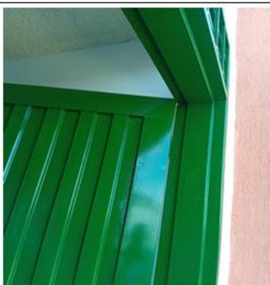
FOTO No 3 PINTURA DE PUERTAS DE AULAS IE MALHABAR SEDE A - JOSÉ RUFINO
