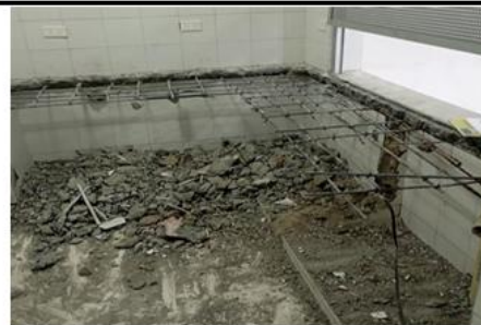
FOTO No 9 DEMOLICIÓN DE MESÓN IE SANTO DOMINGO SAVIO
