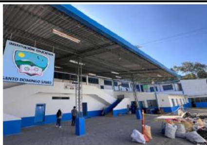
FOTO No 9 PINTURA DE MUROS DE PATIO IE SANTO DOMINGO SAVIO
