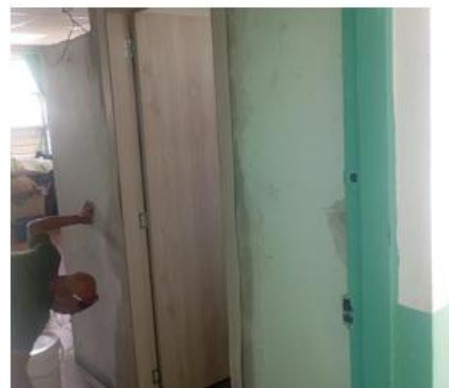
FOTO No 2 PINTURA DE MURO INNGRESO A BAÑO IE MALHABAR SEDE B – FRANCISCO GIRALDO
