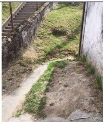
FOTO No 5 - RETIRO DE ESCOMBROS IE MALHABAR SEDE PRINCIPAL
