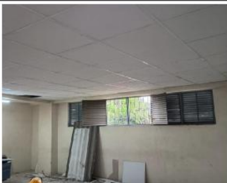
FOTO No 5 - INSTALACIÓN DE ESTRUCTURA DE CIELO RASO IE MALHABAR SEDE PRINCIPAL
