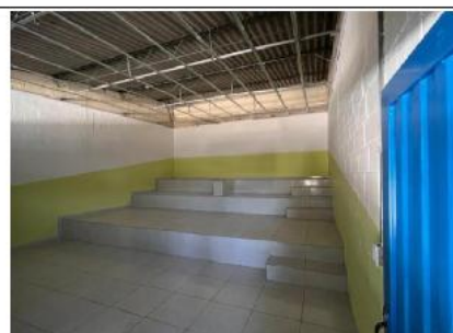
FOTO No 8 PINTURA DE AULAS EN SEGUNDO PISO IE SANTO DOMINGO SAVIO
