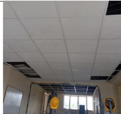
FOTO No 6 INSTALAIÓN DE CIELO RASO IE MALHABAR SEDE PRINCIPAL
