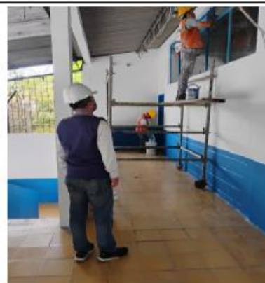
FOTO No 6 PINTURA DE PASILLOS EN SEGUNDO PISO IE SANTO DOMINGO SAVIO
