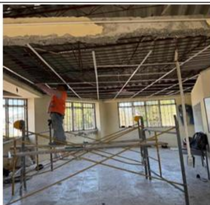
FOTO No 5 - INSTALACIÓN DE ESTRUCTURA DE CIELO RASO IE MALHABAR SEDE PRINCIPAL
