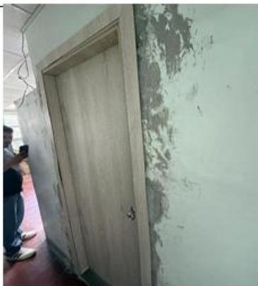
FOTO No1 PREPARACIÓN DE MURO PARA PINTURA IE MALHABAR SEDE B – FRANCISCO GIRALDO
