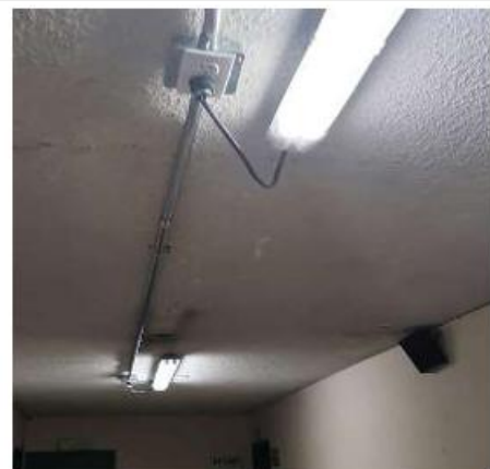
FOTO No 3 INSTALACIÓN DE REDES ELECTRICAS IE MALHABAR SEDE A - JOSÉ RUFINO
