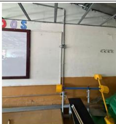
FOTO No 5 - INSTALACIÓN DE REDES ELÉCTRICAS SEGUNDO PISO IE MALHABAR SEDE RUFINO
