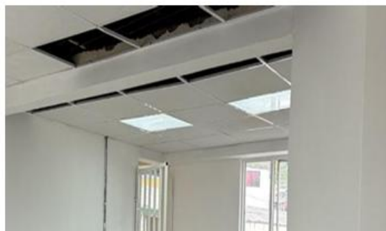
FOTO No 6 PINSTALACIONES ELECTRICAS AULAS IE MALHABAR SEDE PRINCIPAL
