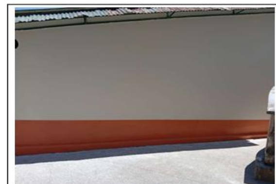
FOTO No 6 PINTURA DE MUROS FACHADAS DE PATIO IE MALHABAR SEDE PRINCIPAL
