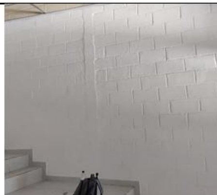
FOTO No 8 PINTURA DE AULAS EN SEGUNDO PISO IE SANTO DOMINGO SAVIO
