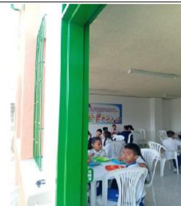
FOTO No 4 CORECCIÓN DE PINTURA EN PUERTAS- COMEDOR IE MALHABAR SEDE A - JOSÉ RUFINO
