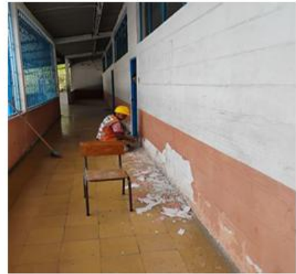
FOTO No 2 PREPARACIÓN DE MUROS PARA PINTURA EN PASILLOS IE SANTO DOMINGO SAVIO
