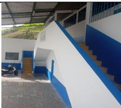
FOTO No 9 PINTURA MUROS ESCALERA IE SANTO DOMINGO SAVIO
