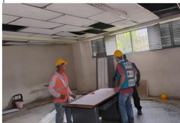
FOTO No 4 DESMONTE CIELO RASO AULA 1 - BLOQUE PALOMERA IE MALHABAR SEDE A - JOSÉ RUFINO
