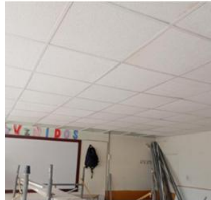
FOTO No 4 INTSALACIÓN DE CIELO RASO EN AULA IE MALHABAR SEDE A - JOSÉ RUFINO
