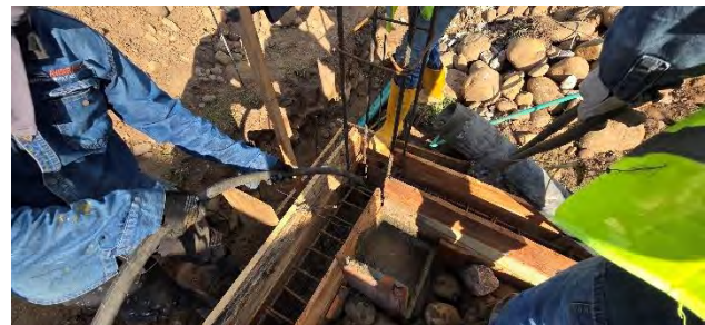
FORMALETA Y FIGURADO DE ACERO LA VELA
