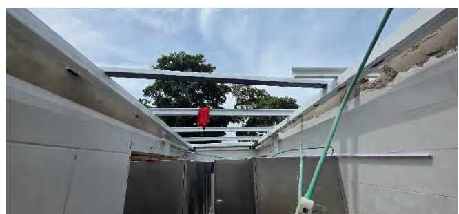
INSTALACION DE LA NUEVA PERFILERIA METALICA PARA LA CUBIERTA DEL ESDEB
