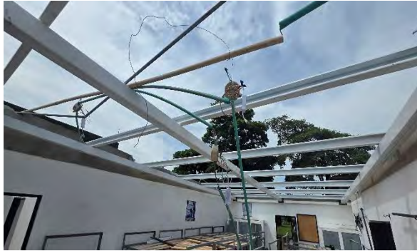
INSTALACION DE LA NUEVA PERFILERIA METALICA PARA LA CUBIERTA DEL ESDEB
