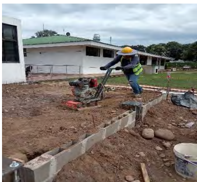
COMPACTACION DE TERRENO
