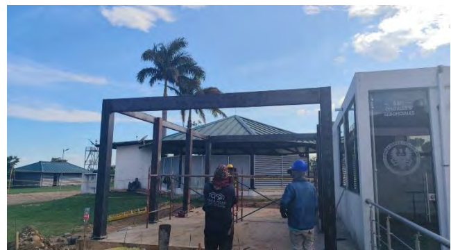
INSTALACION PERFILERIA METALICA
