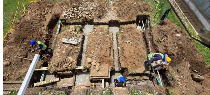
SOLADO DE LIMPIEZA EN EL CASINO
