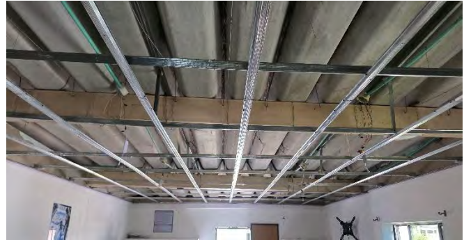
INSTALACION DE LA NUEVA PERFILERIA METALICA PARA LA CUBIERTA DEL ESDEB
