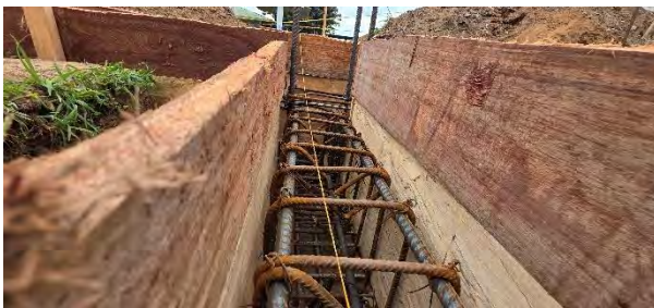
FORMALETA Y FIGURADO DE ACERO LA VELA
