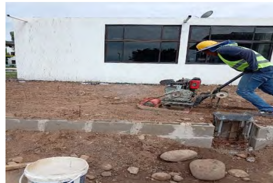
COMPACTACION DE TERRENO
