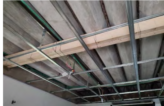
INSTALACION DE LA NUEVA PERFILERIA METALICA PARA LA CUBIERTA DEL ESDEB
