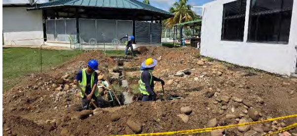
EXCAVACIONES EN EL CASINO
