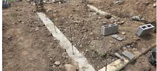
SOLADOS DE LIMPIEZA CASINO LA VELA
