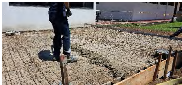
INSTALACION DE MALLA Y CONCRETO POBRE LA VELA
