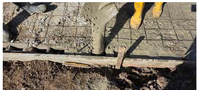
GROUTING PARA MAMPOSTERIA ESTRUCTURAL
