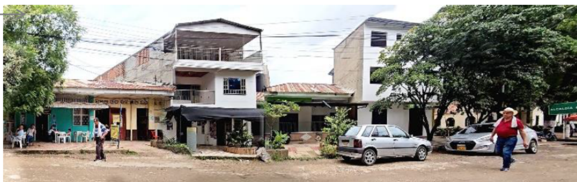
Collage de Fachadas en Calle 9 -Tramo A- Costado Norte. Ref.: Elaboración propia
