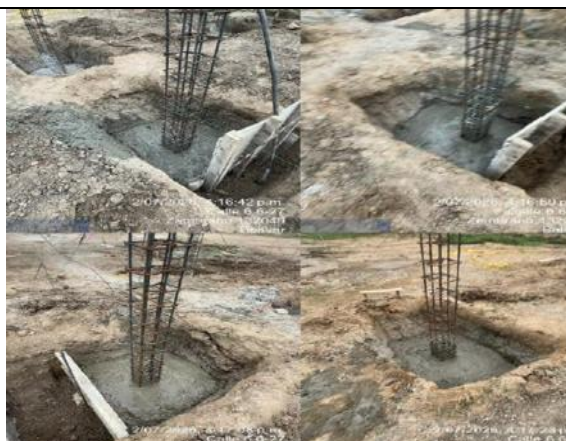
Fundida Zapata Módulo baños
