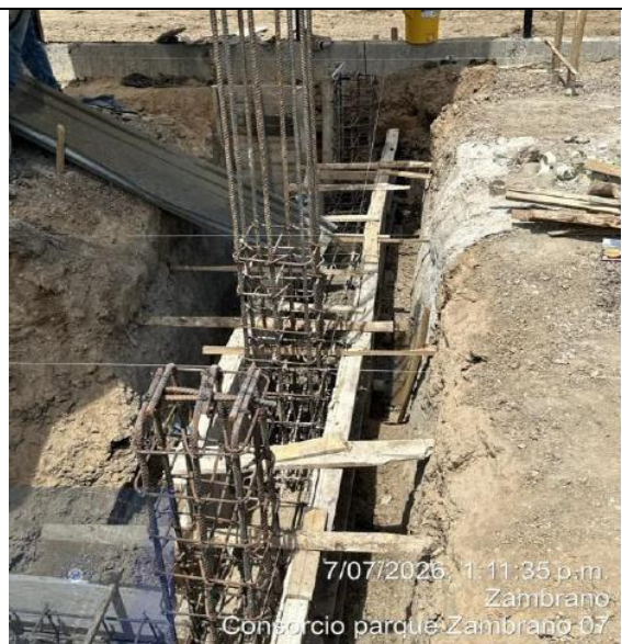
Fundida viga de cimentación Gradass
