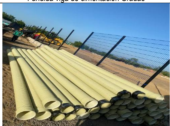
Suministro tubería 8" drenaje exterior
