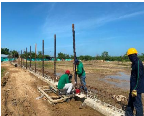
Instalación tuberías cerramiento
