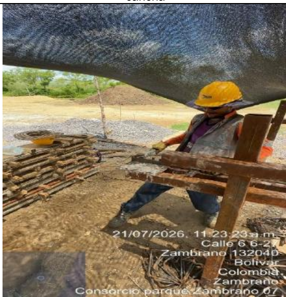
Figurado de acero módulo grada 2
