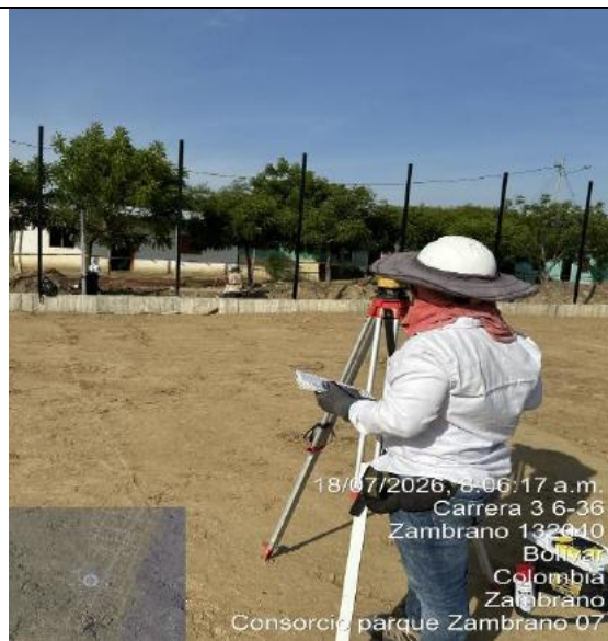
Toma de niveles tubería drenaje exterior
