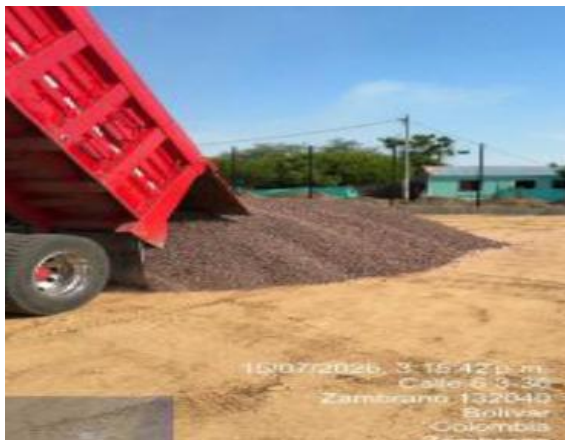
Suministro triturado para drenaje francés interior cancha
