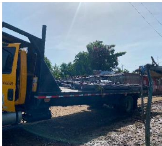
Ingreso de acero
