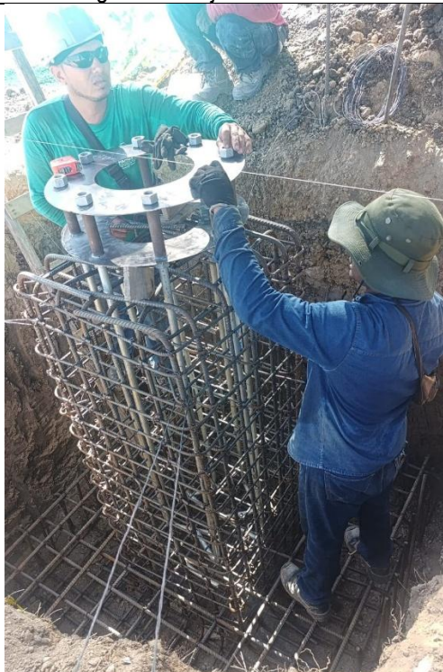
Colocación parrilla columna mástil
