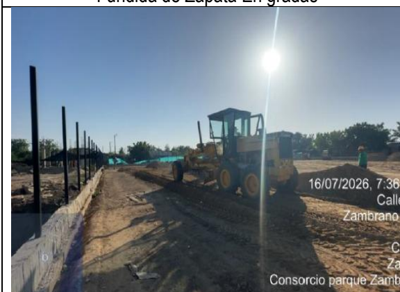
Nivelación y preparación de La cancha
