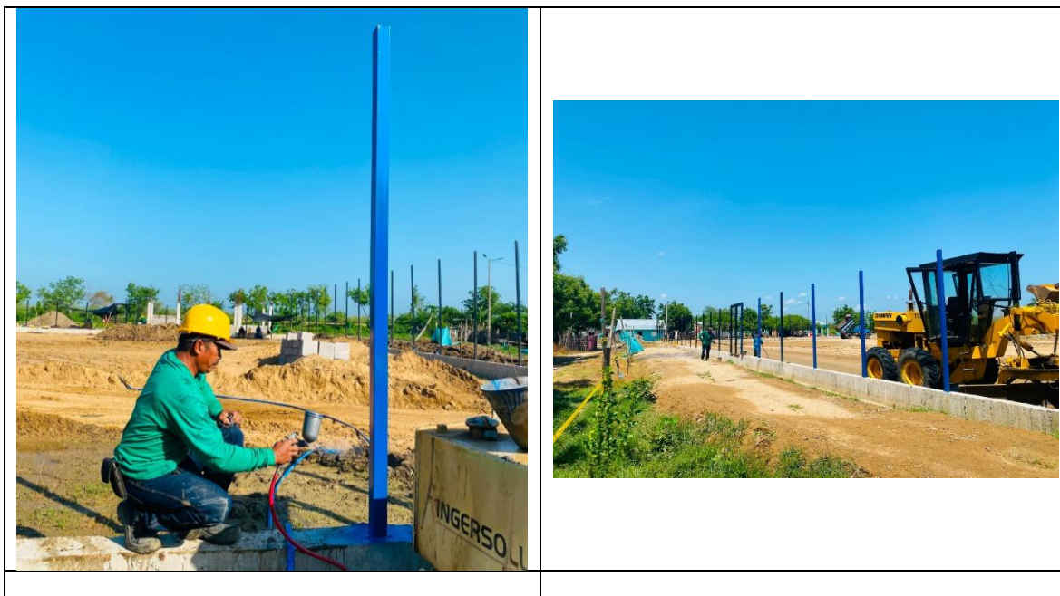
Ilustración 4. Registro fotográfico de actividades obra mes de mayo Fuente: Parque Zambrano 07
