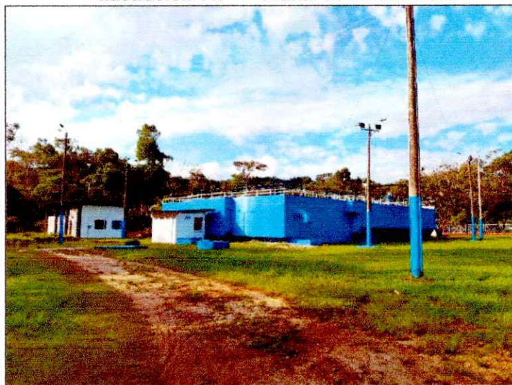
Ilustración 11. Planta de Tratamiento
