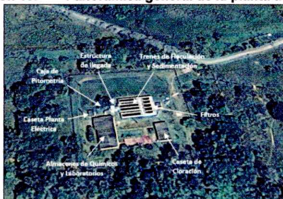
Ilustración 10. Panorámica general de la planta de tratamiento
