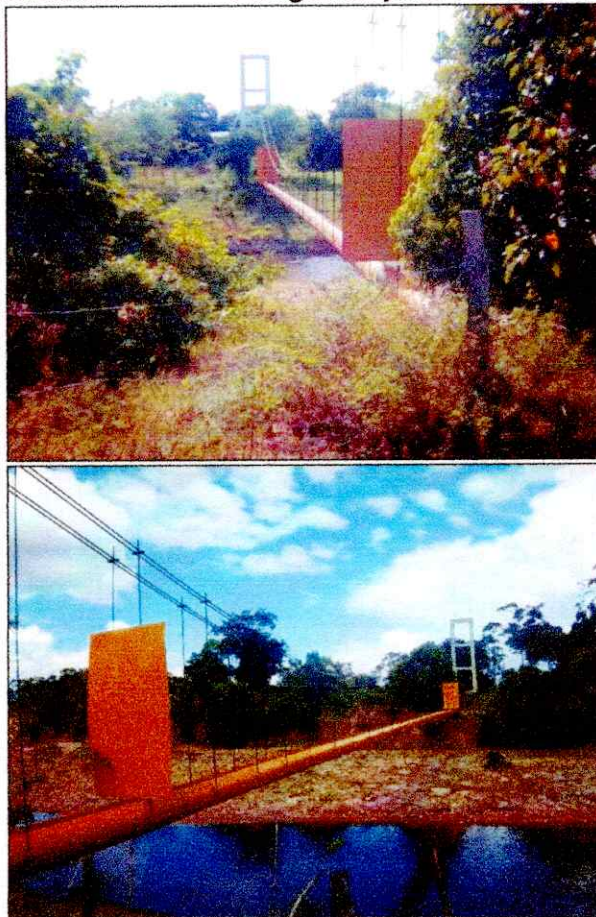
Ilustración 19. Fotografías paso Elevado Calle 32
