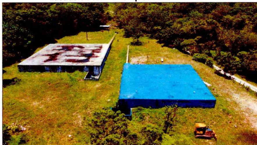
Ilustración 12. Tanques de Almacenamiento
