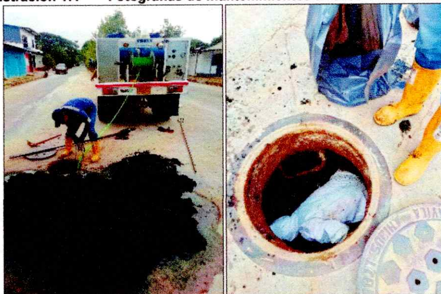
Ilustración 17. Fotografías de mantenimientos a redes de Alcantarillados
