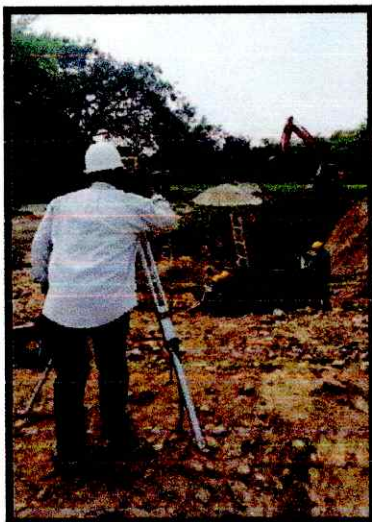
Ilustración 2. Replanteo de pozo de Inspección
