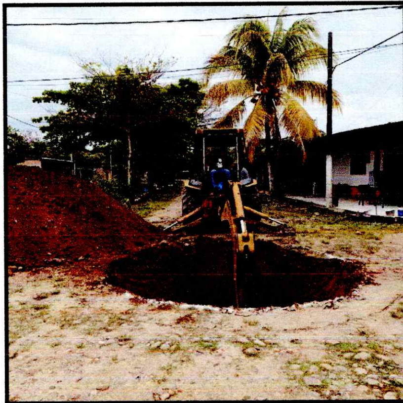
Ilustración 3. Excavación mecánica para la construcción de pozos de inspección
