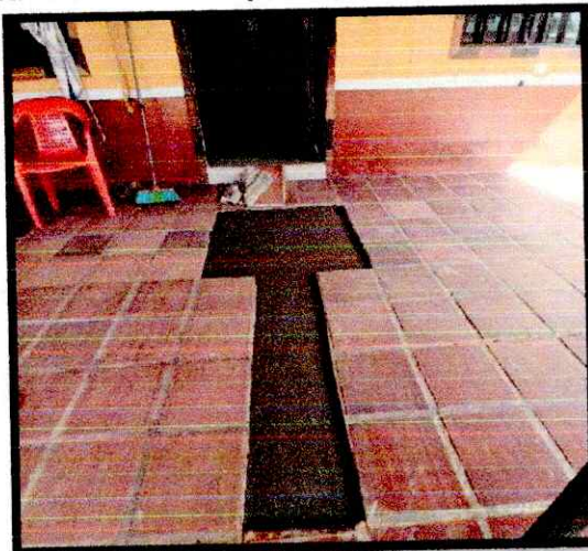
Ilustración 7. Reposición de andenes en concreto
