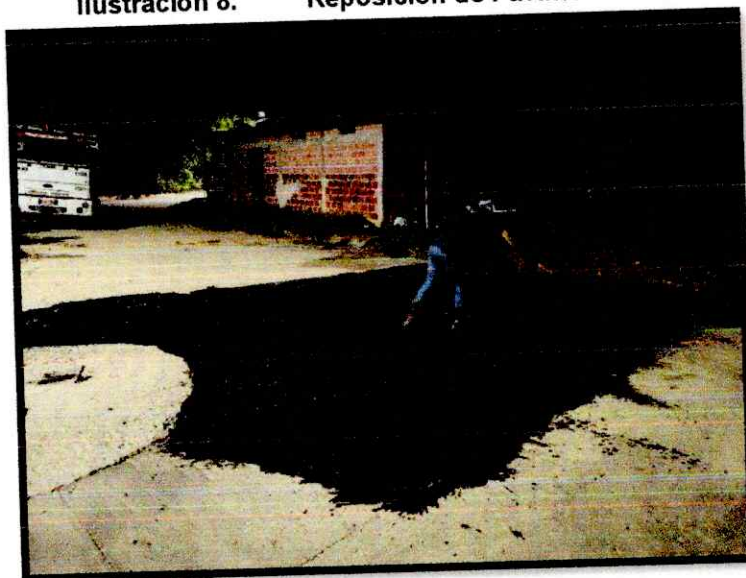
Ilustración 8. Reposición de Pavimento Flexible
