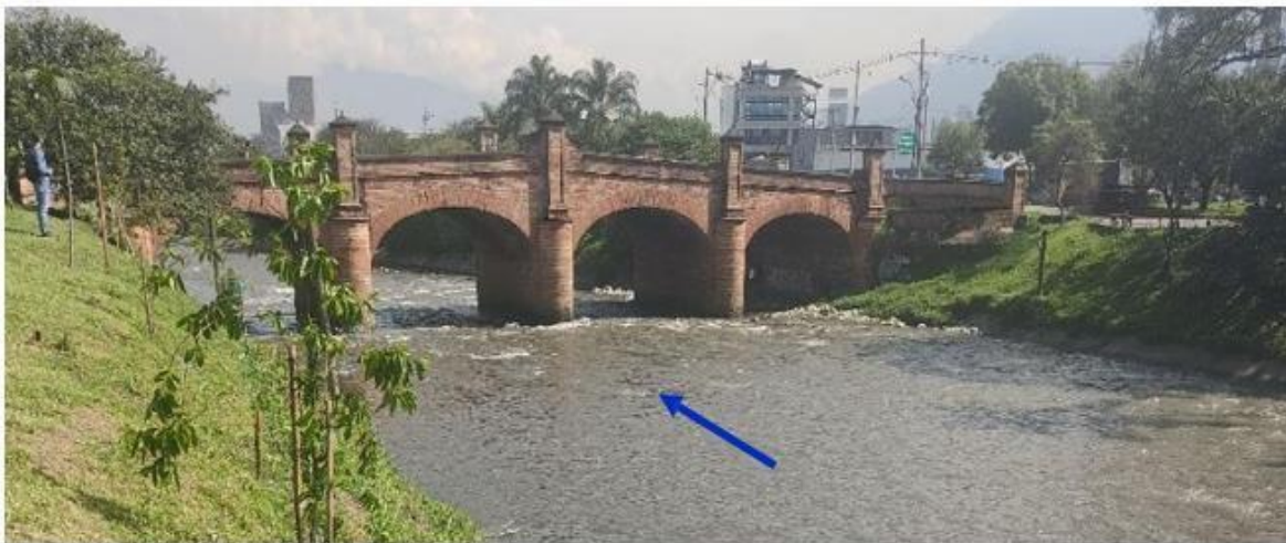
Figura 4. Estructura de Puente Guayaquil en el canal del río Medellín.
