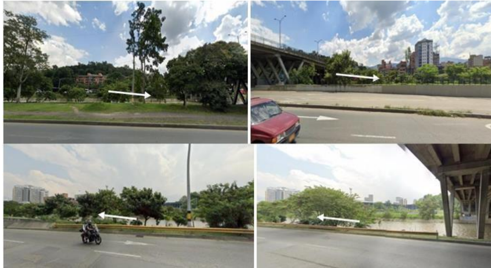
Figura 9. Sector Puente la 33 afectado por desbordamientos del río Medellín, margen derecha (superior) y margen izquierda (inferior, Autopista Sur).
