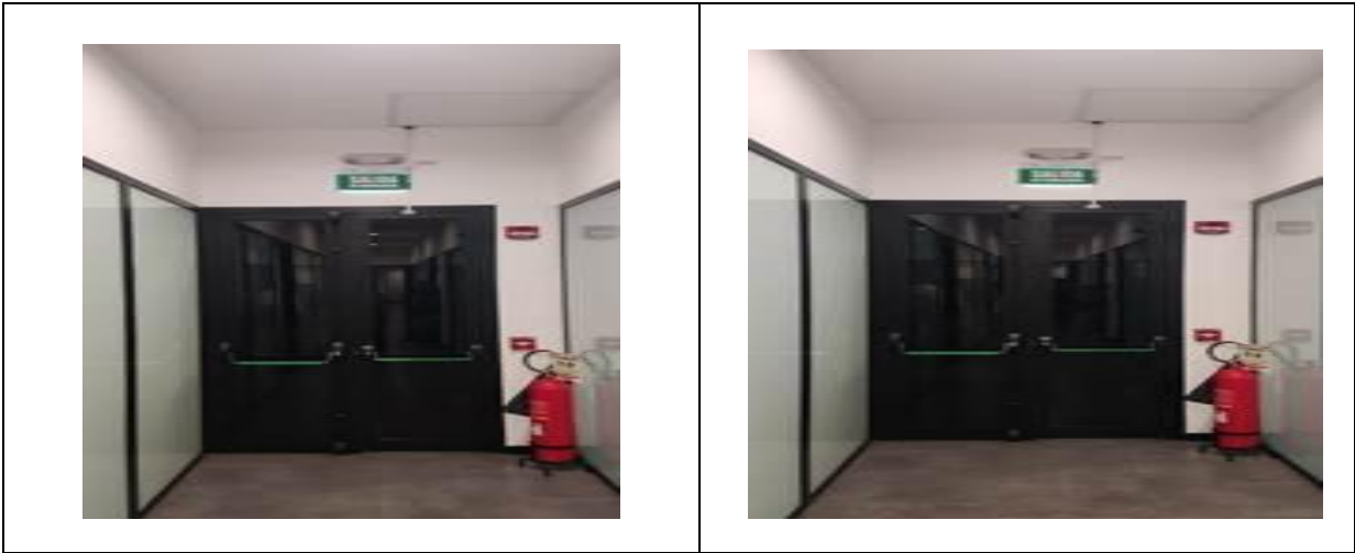
Elementos de emergencia extintores total disponibles 10 unidades
