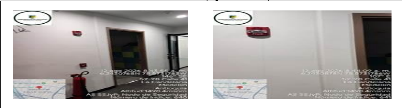
Pasillo Primer Nivel (Ingreso a Baños)
