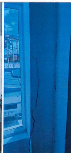
Ilustración 5 fisuras verticales en muros divisorios que no afectan la integridad estructural
