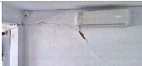
Ilustración 111 vista interior ampliación, detalle de apoyos deteriorados
