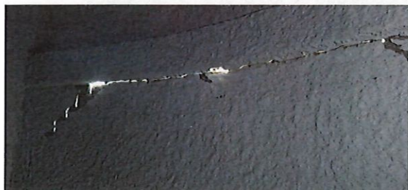
Ilustración 6 vista interna de la separación entre muros de cerramiento y pórticos
