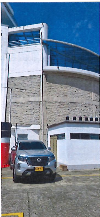
Ilustración 2 vista exterior muros en mampostería de ladrillo abujardado
