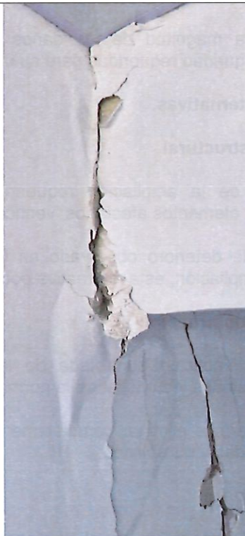
Ilustración 111 vista interior ampliación, detalle de apoyos deteriorados
