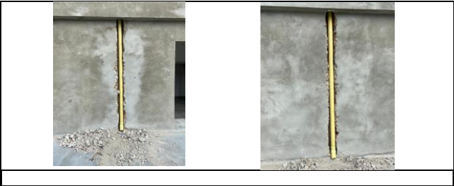
UBICACIÓN: TERRAZA DEL TERCER PISO COMENTARIOS: ARREGLO DE BAJANTE DE AGUA LLUVIA
