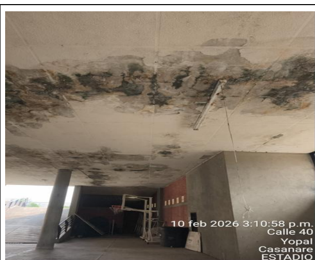
Foto 17-18 se evidencia desprendimiento de graniplast así como humedad
