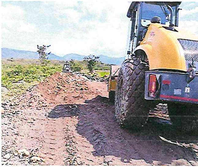
Ilustración 5 Maquinaria Amarilla Operativa
