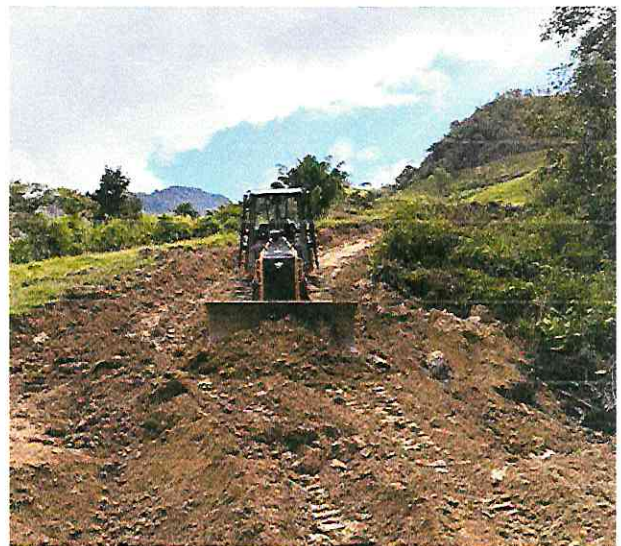
Ilustración 6 Maquinaria Amarilla Operativa
