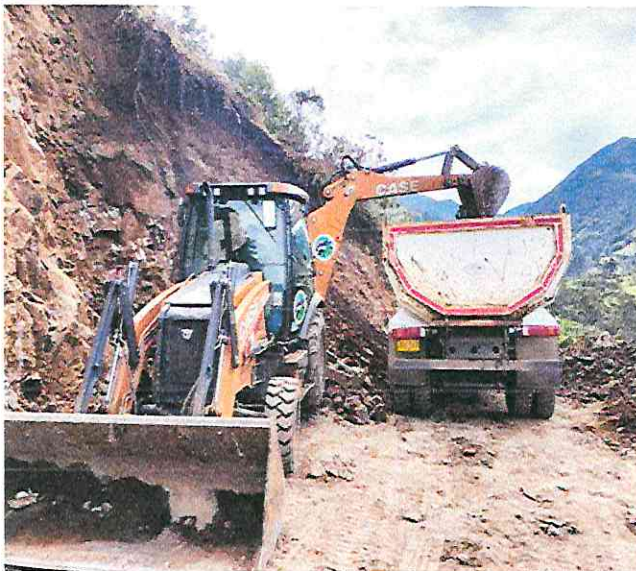
Ilustración 7 Maquinaria Amarilla Operativa
