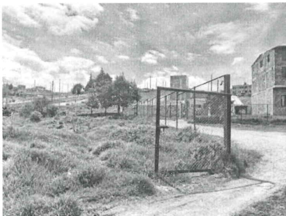
Fig. 3. Estado actual zona a intervenir.
