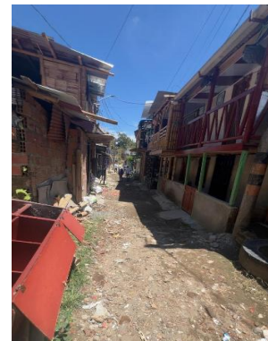
ACENTAMIENTO DE VIVIENDAS, CORREDOR FERREO
