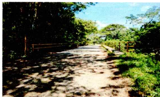
ESTRUCTURA HIDRÁULICA EXISTENTE (Puente Caño Gualabao)
